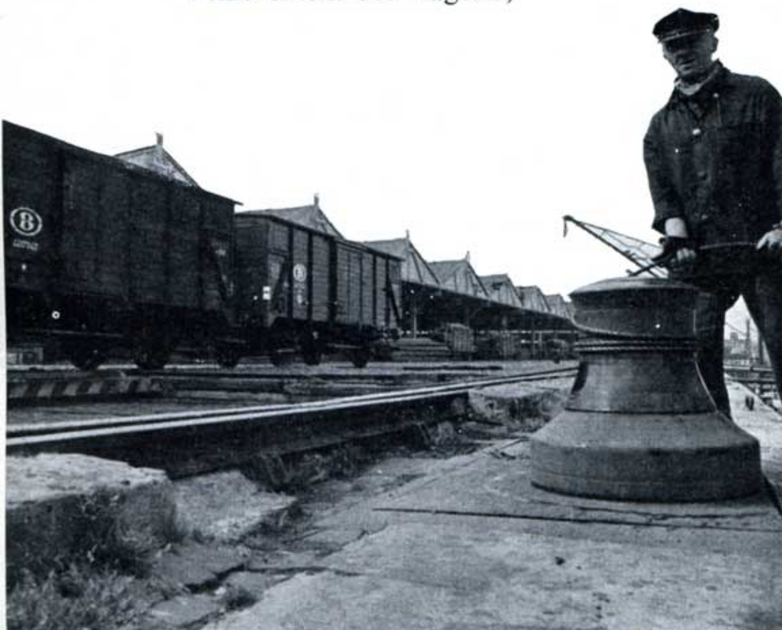
Cabestan pour manœuvre du pont transbordeur.
