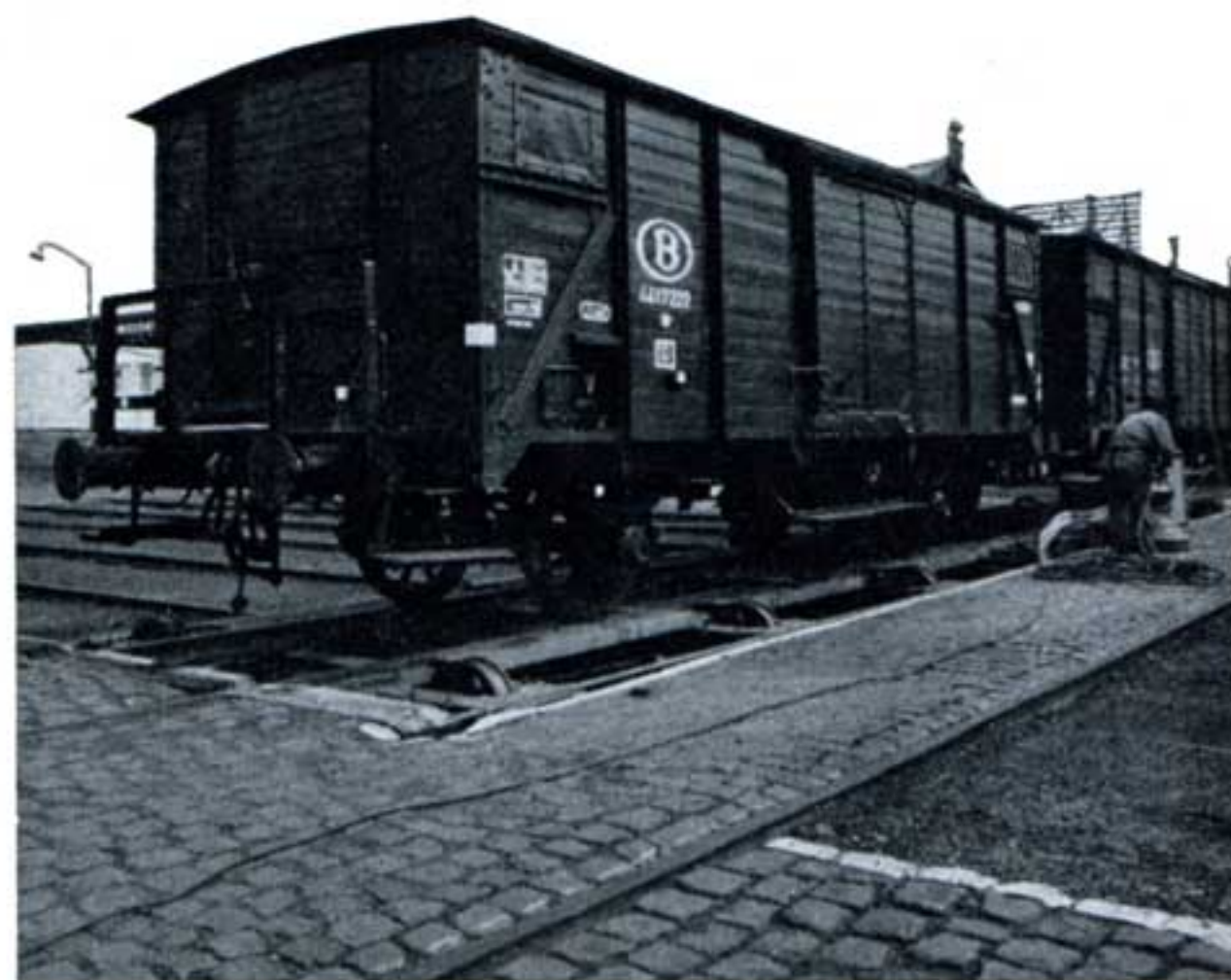
Pont transbordeur manœuvré par cabestan.
