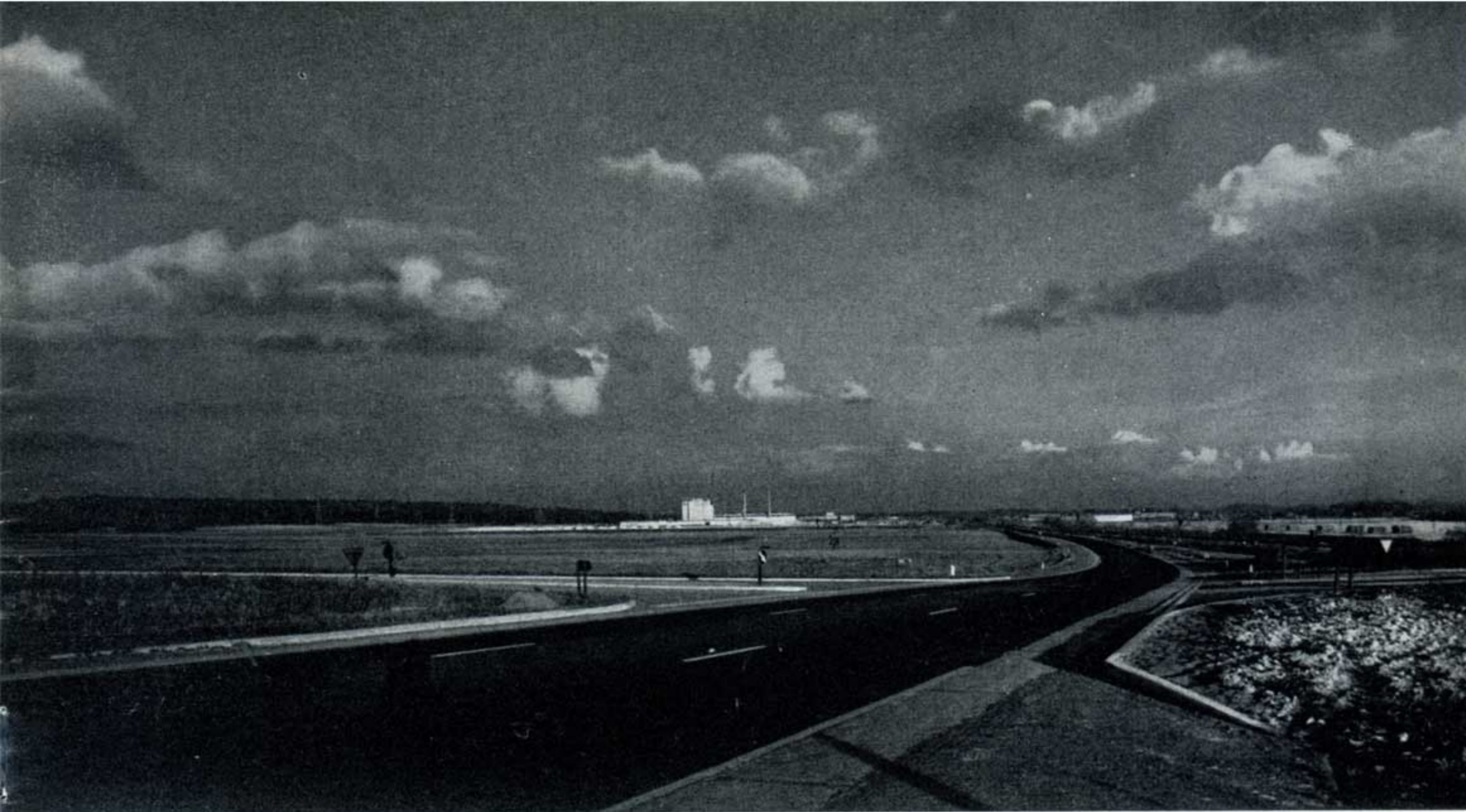
Vue générale du zoning Ghlin-Baudour.
