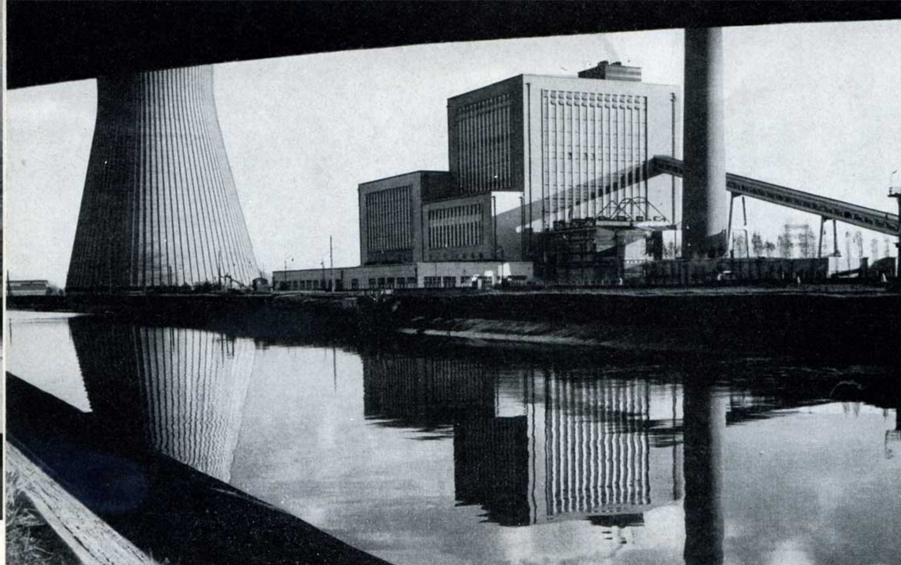
La centrale électrique de Baudour.
