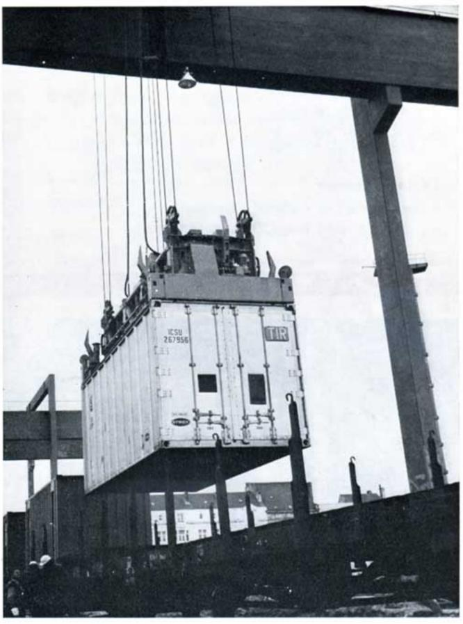
Le transcontainer est comme le commun dénominateur qui permet aux trois modes de transport, l'eau, la route, le rail, de s'additionner. Mais il faut pour cette opération un équipement adéquat. C'est la raison pour laquelle les gares terminales sont équipées de ponts transbordeurs d'une force de levage de 25 à 30 tonnes, gràce auxquels le transbordement s'effectue rapidement et sans difficulté.
