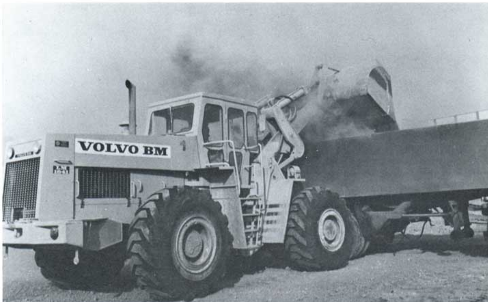
1er temps : des pelles mécaniques chargent les camions.
