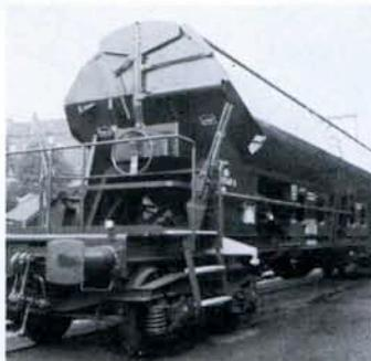
Véhicules autodéchargeurs à bogies, les Tads sont particulièrement destinés au transport de marchandises en vrac qui craignent les intempéries, comme la chaux, le sable, la dolomie, les engrais en granules, etc. La toiture amovible opère cette protection; mais ouverte pour le chargement, elle dégage une surface utile de 12,7 x 1,2 m.
