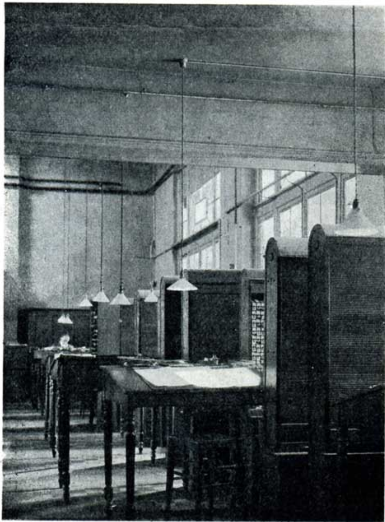
Intérieur des bureaux avant
