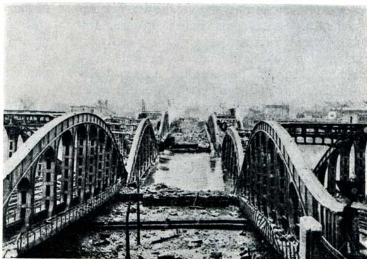
LIÈGE - Les nouveaux Ponts du Val-Benoît, après la catastrophe
