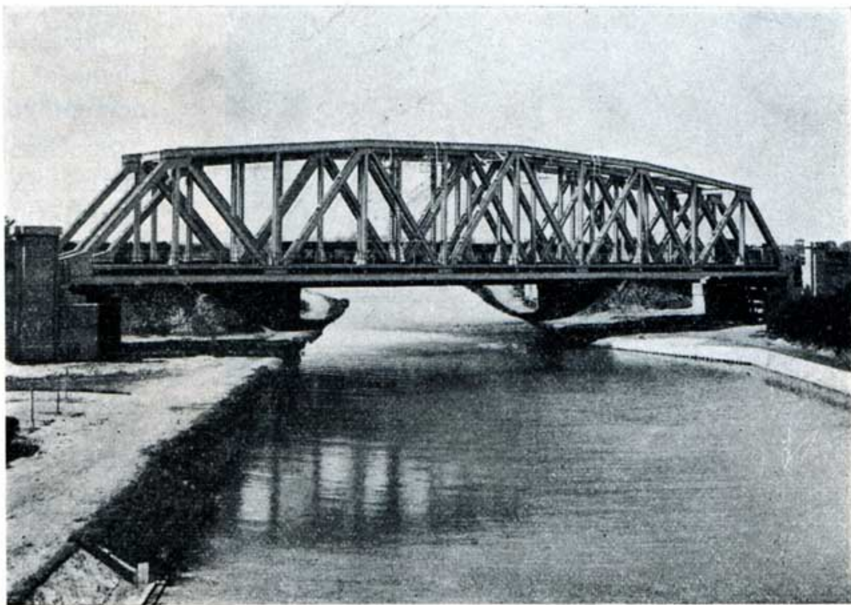
Tabliers d'Oolen. — Vue générale
