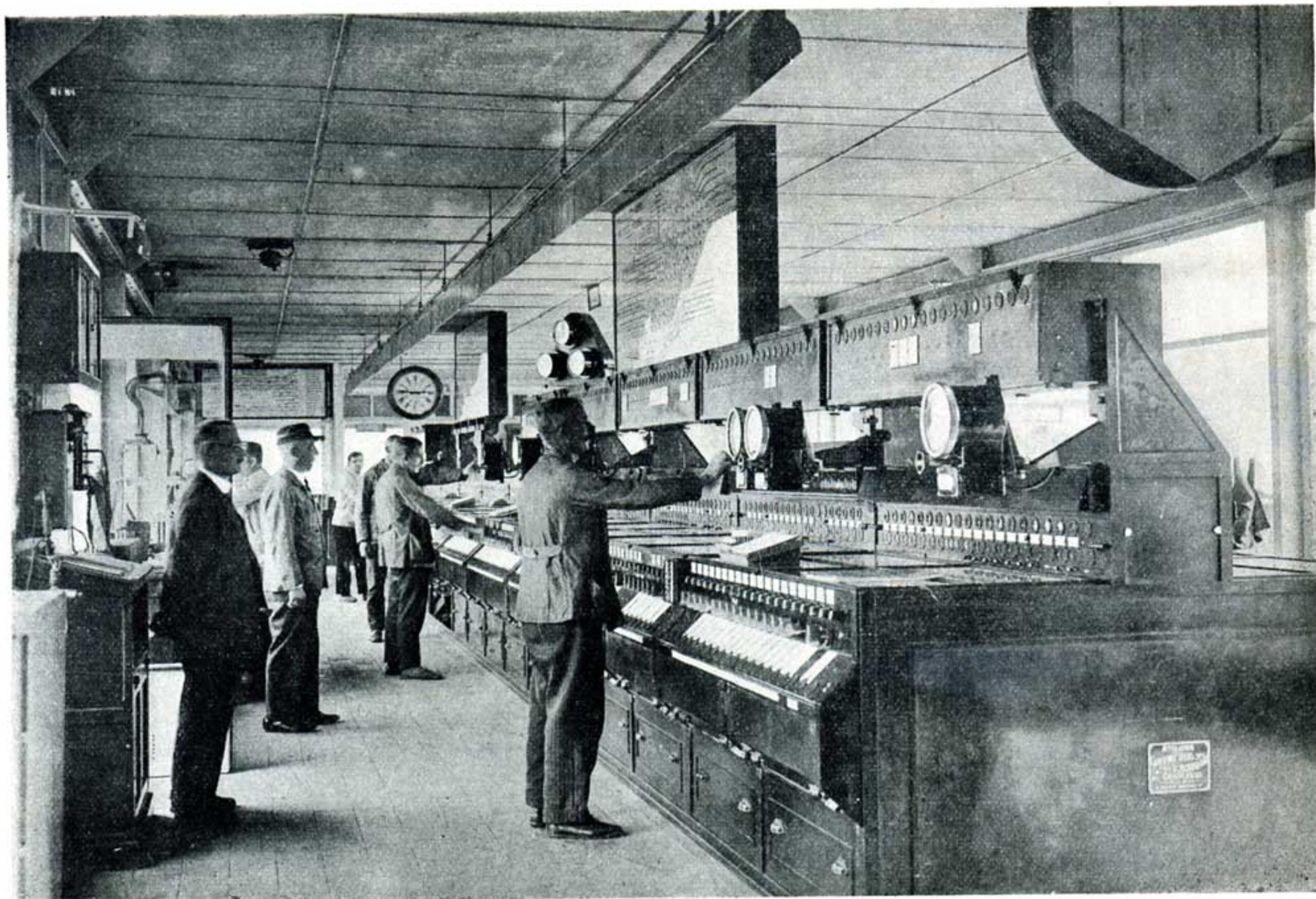
Cabine de signalisation de Bruxelles-Nord.
