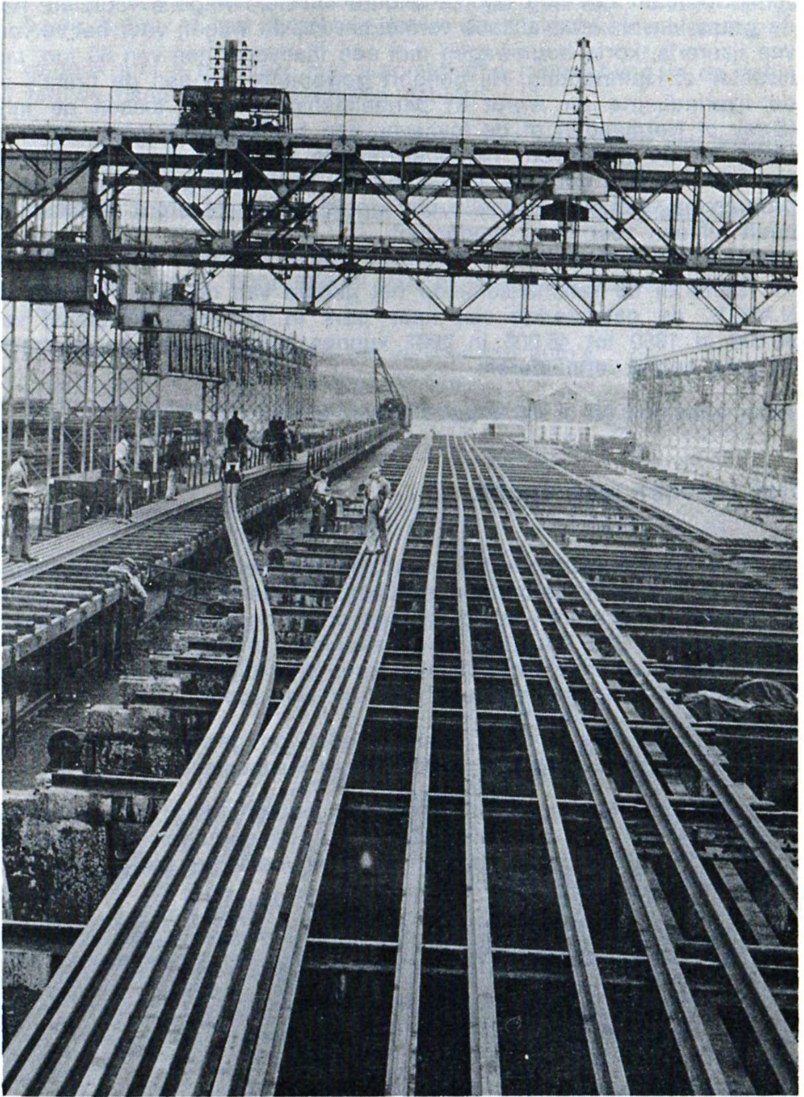
Fig. 9. — Laden van lange gelaste rails (216 m) in de Centrale Stapelplaats van de Baan te Schaarbeek.
