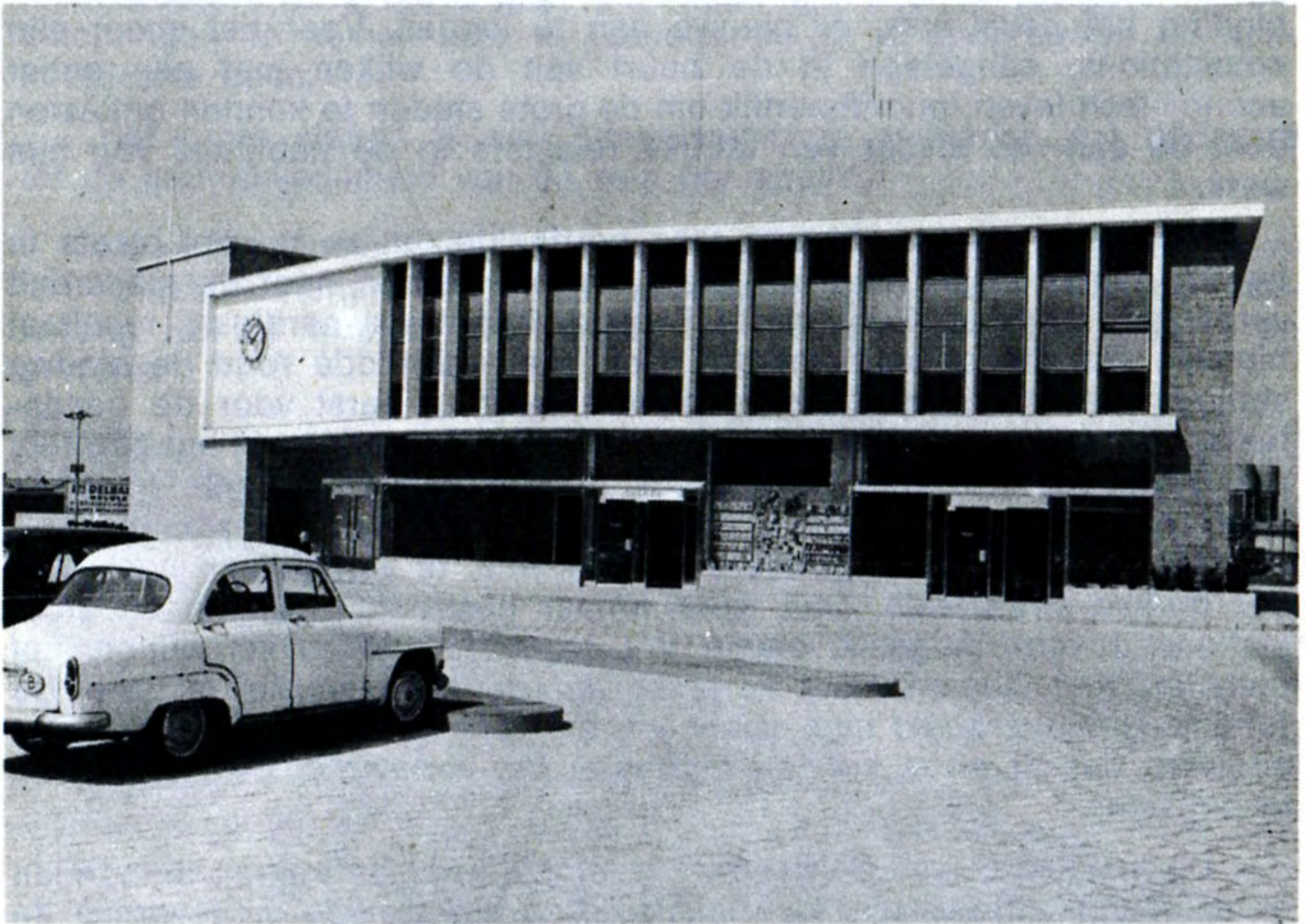
Fig. 11. — Nieuw stationsgebouw te La Louvière.
