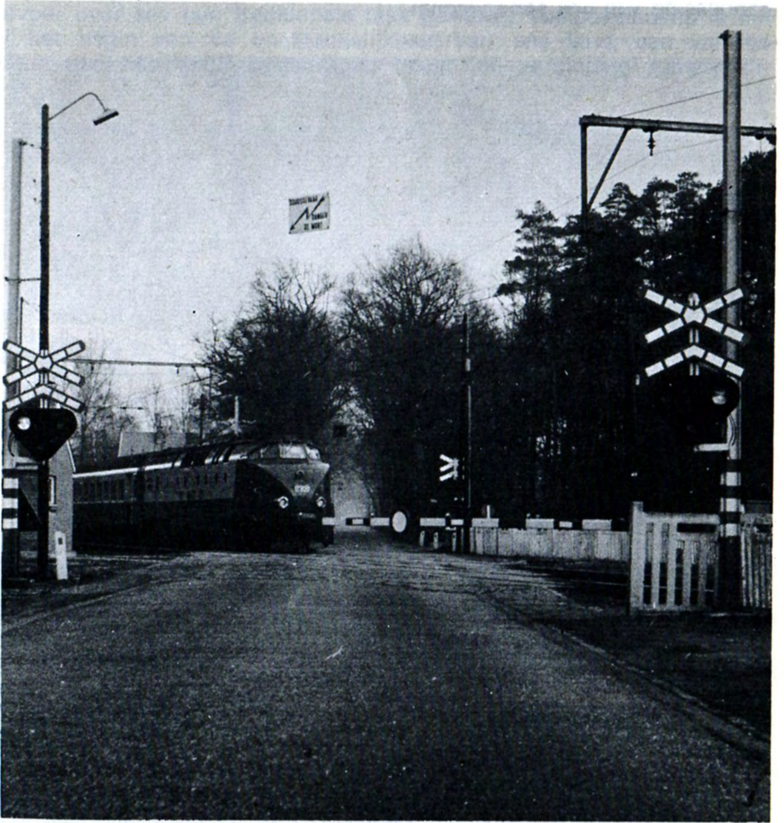
Fig. 13. — Overweg met automatische halve slagbomen, bellen en lichtseinen. Het verkeersreglement kent op de kruisingen van spoor en weg absolute voorrang toe aan het spoor. De N.M.B.S. doet beroep op al de weggebruikers opdat zij bij het naderen van de overwegen de grootste tucht en voorzichtigheid in acht zouden nemen.
