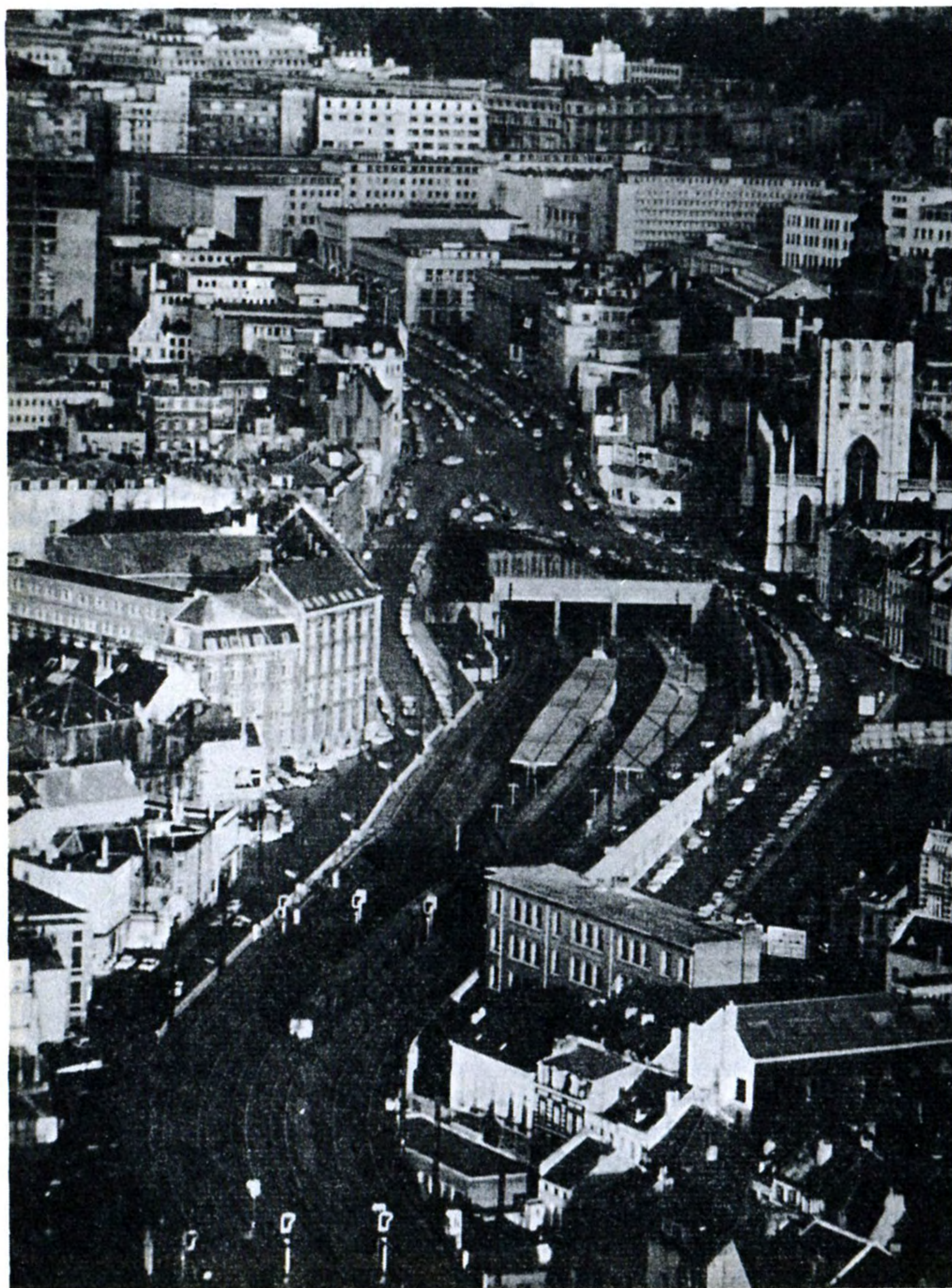
Fig. 6. — De spoorweg brengt de reizigers tot in het hart van de stad. Ingang van de Noord - Zuidverbindingstunnel kant Brussel - Zuid.
