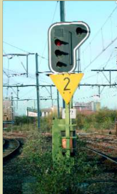
Hier een stopsein dat nog een oud snelheidsbord draagt. Dit model van snelheidsbord wordt geleidelijk vervangen door het nieuwe type. In dit geval wordt de bestuurder een maximale snelheid van 20 km/h vanaf de eerste wissel opgelegd. Schaarbeek, 5 april 2006.
