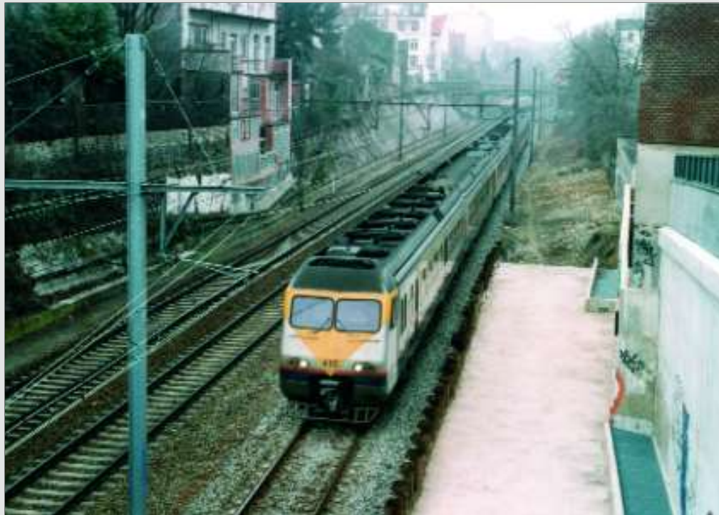
Halverwege Brussel-Luxemburg en Etterbeek, doortocht van een IC M Brussel-Zuid - Namur - Liers op het derde spoor. De nieuwe halte Mouterij zal ingeplant worden ter hoogte van de brug zichtbaar aan het einde van de trein. Links bevinden zich de beide sporen van lijn 161; rechts ontplooit zich de bedding van het vierde spoor. Christian DOSOGNE, 19 maart 2006.
