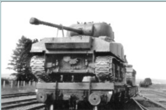
Twee documenten, die zich jammer genoeg in slechte staat bevinden, van een Laalp aangepast voor het tankvervoer. De linker foto werd in Sourbrodt genomen op een onbekende datum. Een "Sherman"-tank wordt op de wagen geladen. We zien duidelijk de balk die op het uiteinde van de wagen werd bevestigd. De rechter foto werd op 20 juli 1950 in Spa genomen. De soldaat liet zich fotograferen om een souvenir te kunnen sturen aan zijn ouders of zijn vriendinnetje. De "Sherman"-tanks geladen op twee treinen wachten op het vertrek naar Köln om deel te nemen aan een defilé van het eerste regiment Lansiers. Rechts op de foto zien we de oude bottelarij van "Spa Monopole" die in 1980/1981 zal worden afgebroken. Links de watertoren uit 1936, afgebroken in juni 1979.
