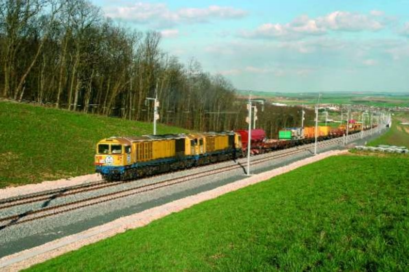
FOTO 74-23 De firma TSO (Travaux du Sud-Ouest) huurt ook enkele locomotieven van de Class 58. Een elektrificatietrein gesleept door 58033 en 58049 in de omgeving van Champey-sur-Moselle. Pierre HERBIET, 6 april 2006.
