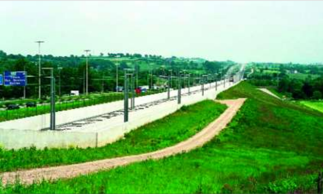
De bedding van L4 is gebetonneerd. De palen staan op ingegoten sokkels in de bedding. De dwarsliggers worden, net als de eerste ballastlaag, per vrachtwagen aangevoerd. Baudouin DIEU, 7 juni 2006.
