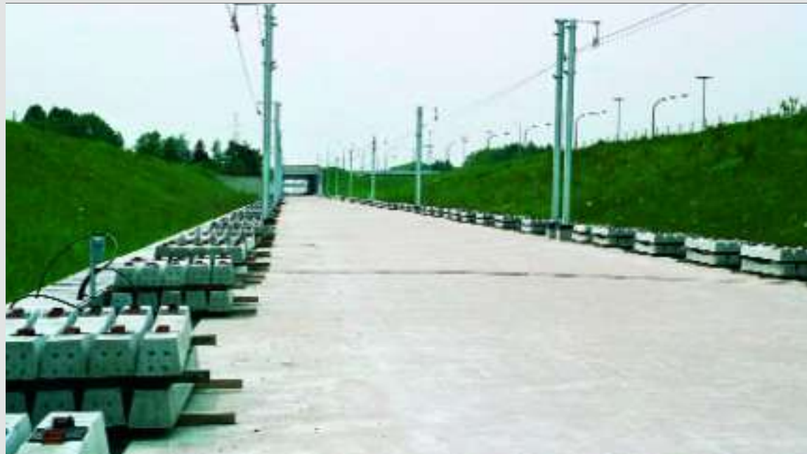
De bedding van L4 is gebetonneerd. De palen staan op ingegoten sokkels in de bedding. De dwarsliggers worden, net als de eerste ballastlaag, per vrachtwagen aangevoerd. Baudouin DIEU, 7 juni 2006.
