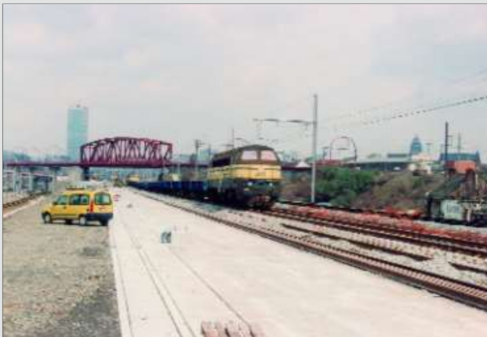
Tussen Vorst en Brussel-Zuid werd ballast aangebracht op de betonnen bedding voor de snelsporen. De 5311 (van de TUC-Rail-werkbasis van Schaarbeek) op kop van een trein met Nederlandse platte wagens nabij de Vierendeelbrug van de lijn 28/3. Baudouin DIEU, 2 mei 2006.
