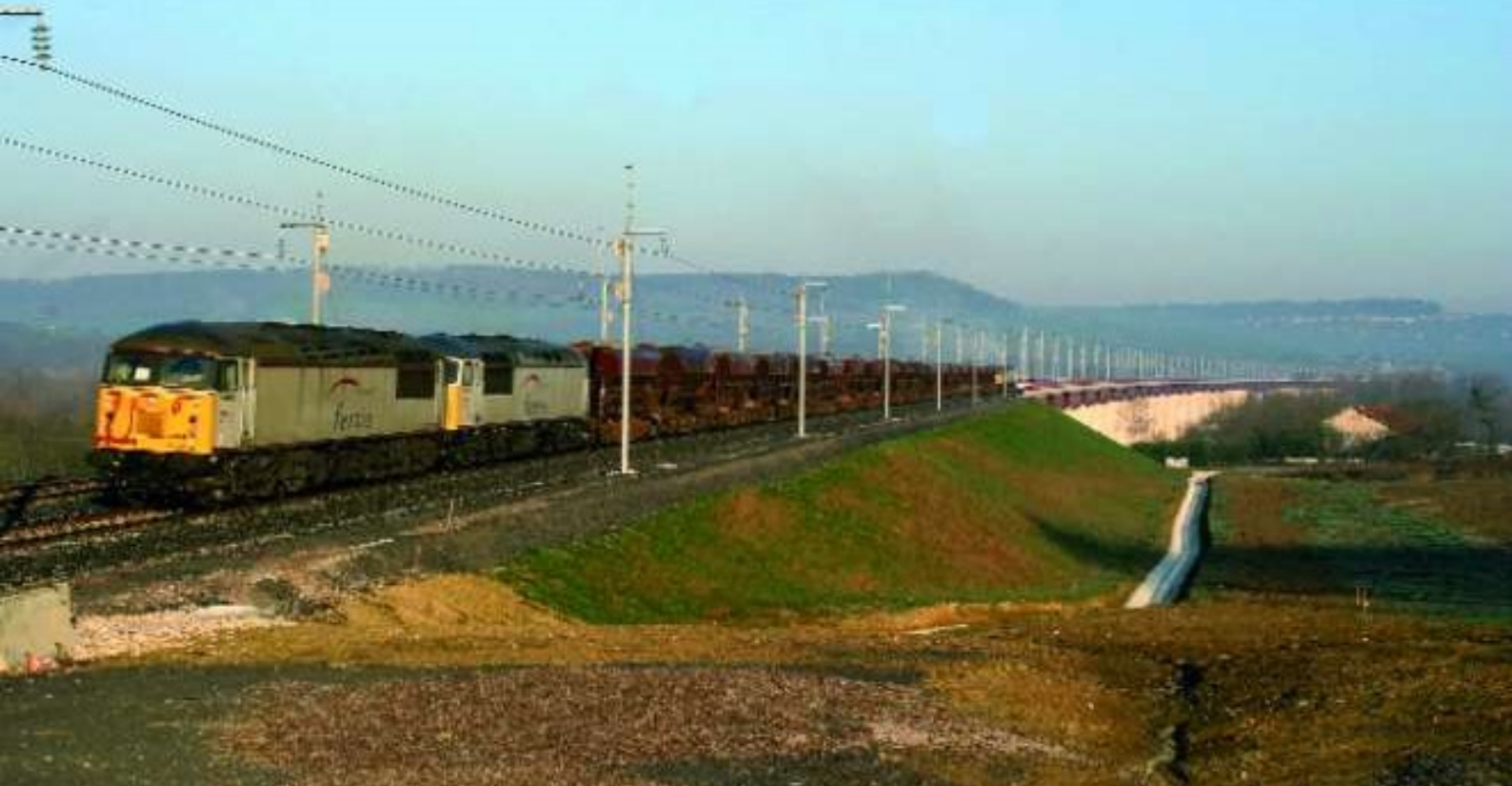
FOTO 74-25 Een ballasttrein rijdt over het viaduct van Champey-sur-Moselle. Met een lengte van 1500 meter is dit het langste viaduct op de LGV Est. Op kop de 58069 en 58104. Pierre HERBIET, 6 april 2006.
