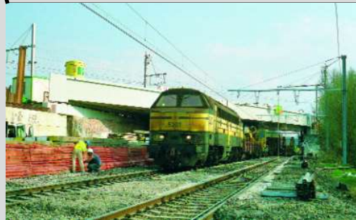
Een werktrein op het spoor naar Namur, te Watermaal. De nieuwe brug van lijn 26 ligt op haar plaats. De toekomstige halte "Arcaden" zal deels op de brug liggen. Christian DOSOGNE, 9 april 2007.
