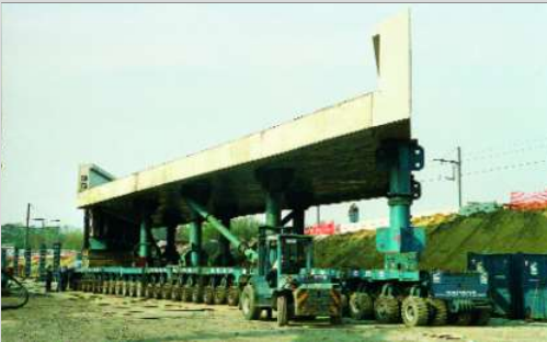
Eén van de twee nieuwe brugdekken te Watermaal, waardoor lijn 26 lijn 161 kan oversteken. We zien hier de speciale trein het brugdek op zijn plaats zetten. Hieronder een ander zicht op het brugdek. Rechts de kraan, maar nu gericht naar het spoor richting Namur op lijn 161. Christian DOSOGNE, 6 april 2007.
