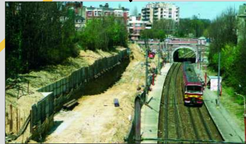
De nieuwe tunnel Shuman - Josaphat ter hoogte van de huidige halte Meiser van lijn 26. Christian DOSOGNE, 16 april 2007.
