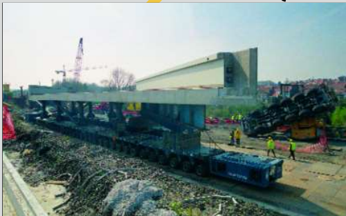
Eén van de twee nieuwe brugdekken te Watermaal, waardoor lijn 26 lijn 161 kan oversteken. We zien hier de speciale trein het brugdek op zijn plaats zetten. Hieronder een ander zicht op het brugdek. Rechts de kraan, maar nu gericht naar het spoor richting Namur op lijn 161. Christian DOSOGNE, 6 april 2007.
