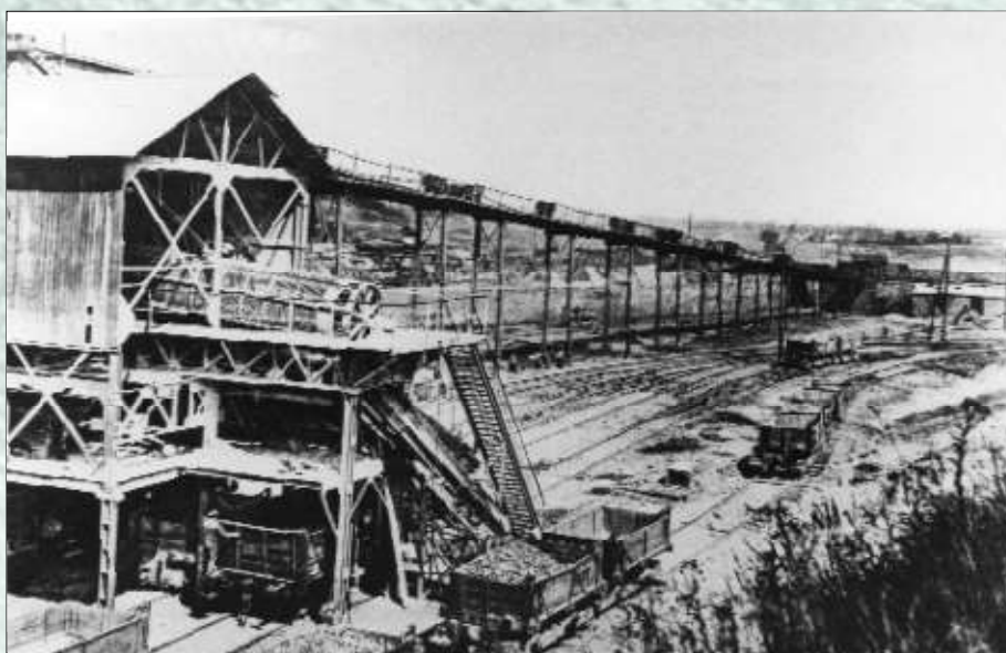
De breekmolen van Tacquenier. De wagentjes worden van beneden naar boven getrokken door het kettingsmechanisme. Op de voorgrond zien we twee kleine platte wagens voor het vervoer van afval. Wagens van de Belgische Staat worden onder-tussen beladen. Verzameling Michel DUHAUT.
