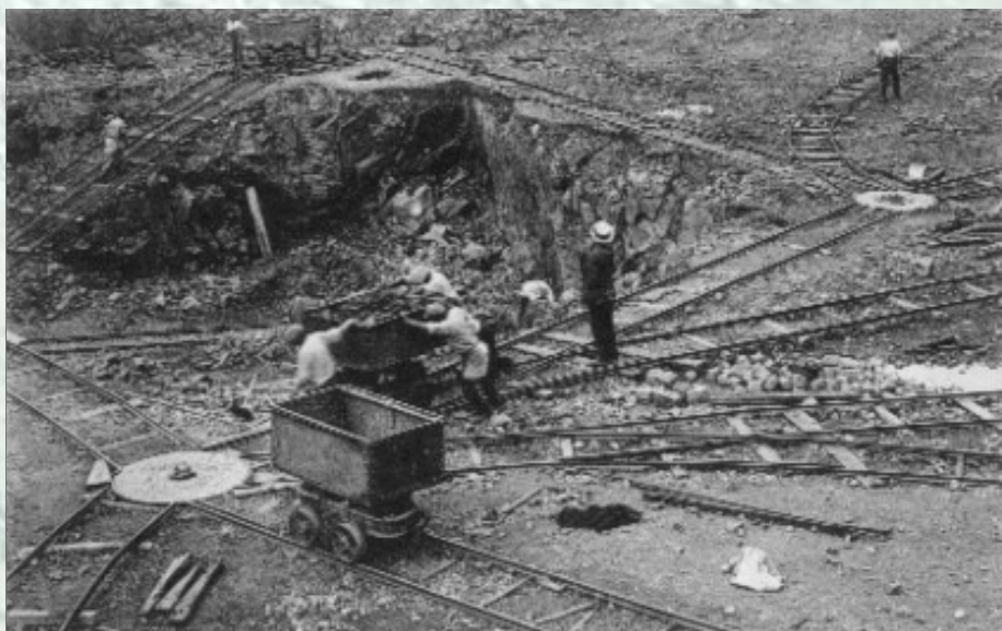
Een zicht op de bodem van de steengroeve, vlak bij het boorvlak. We zien een wirwar van Decauville-spoor, draaischijven en wissels waardoor alle ontginningspunten bereikbaar waren. Linksachter een hellend vlak langswaar de wagentjes door middel van een trek-kabel werden opgehesen.
