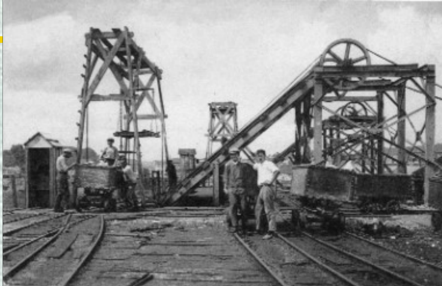
De groeve Vandevelde telde twee hellende vlakken voor draagkarren op het enige dwarsspoor. Twee luchtbruggen, verbonden met een kettingsysteem en katrollen, verzekerden doorlopend het transport en vulden nonstop onderaan de lege wagentjes. Een van de luchtbruggen is opgehangen aan een windas, zichtbaar rechts op de foto. Prentbriefkaart Hanon, verzameling Michel DUHAUT.
