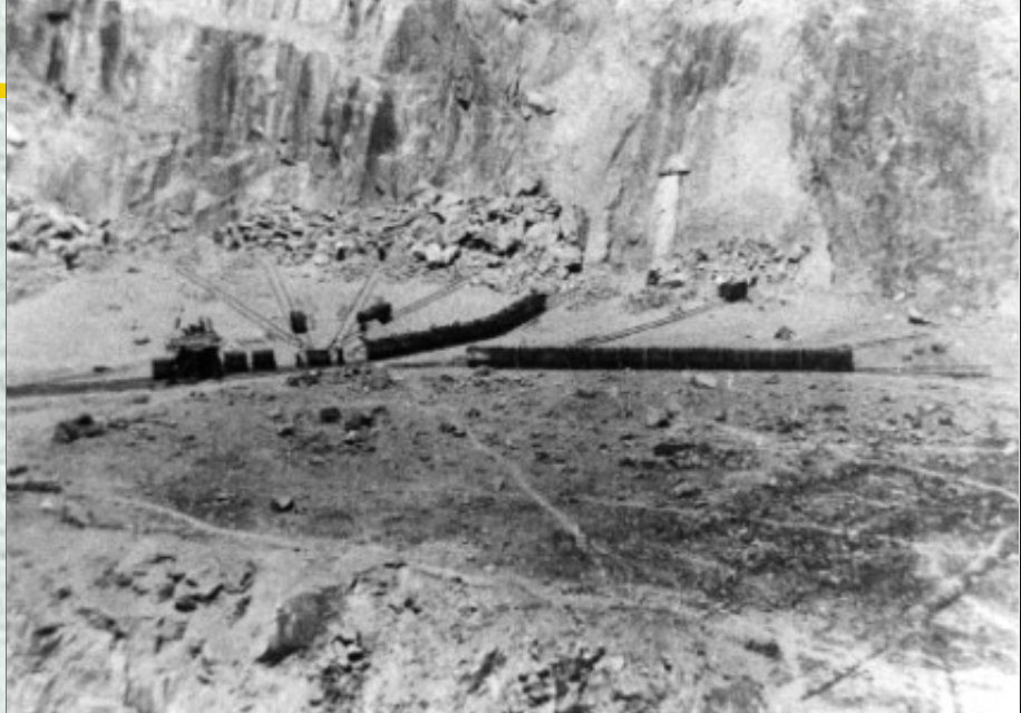
Deze twee foto's tonen het diepste punt van de groeven Tacquenier en Cosyns met de talrijke verplaatsbare, in waaivorm aangelegde sporen, tot tegen de ontginningsplaats voor de afvoer van de stenen naar de verwerkinginstallatie. De onderste foto dateert van 1920.
