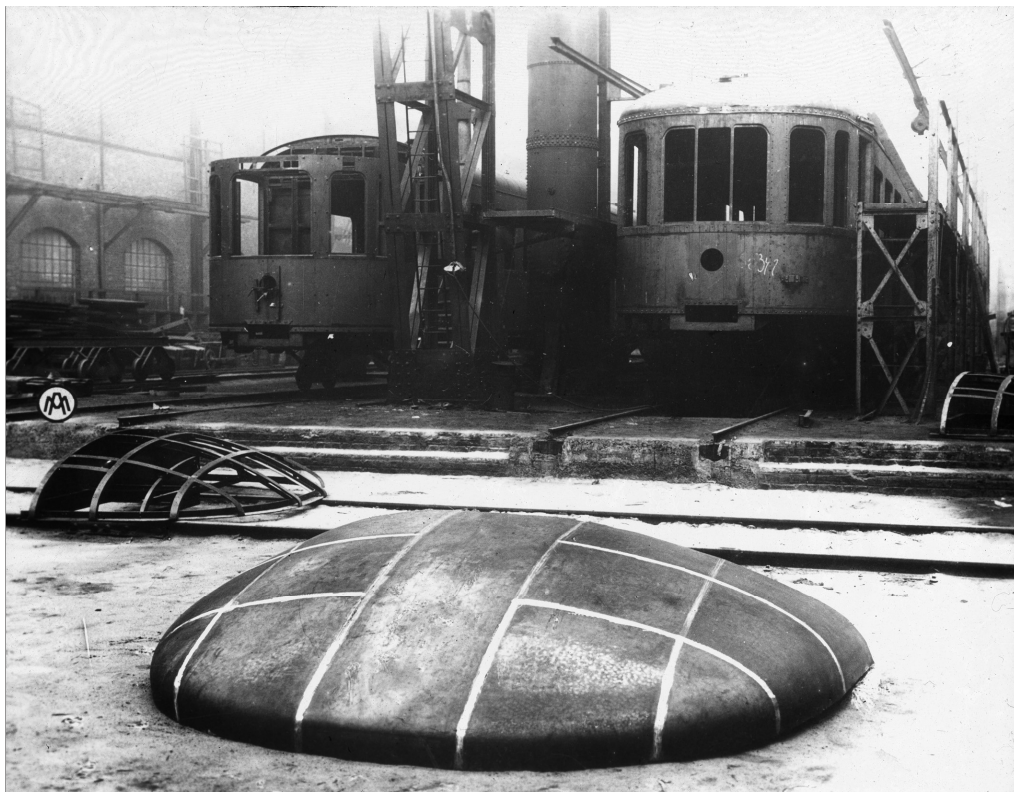
Assemblage van de rijtuigkasten van de motorstellen type 1935 in de Ateliers Métallurgiques de Nivelles. Vooraan zien we het geraamte en de afgeronde dakrand van het motorstel. Foto AMN Nivelles, verzameling TSP ©.
