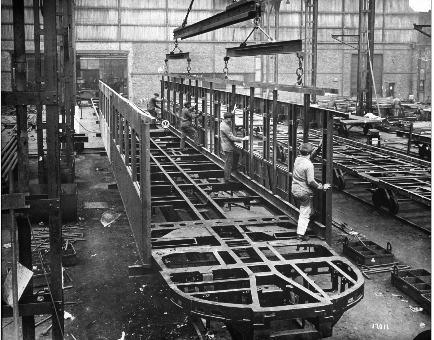
De plaatsing van de langswanden van een motorstel op het chassis.
