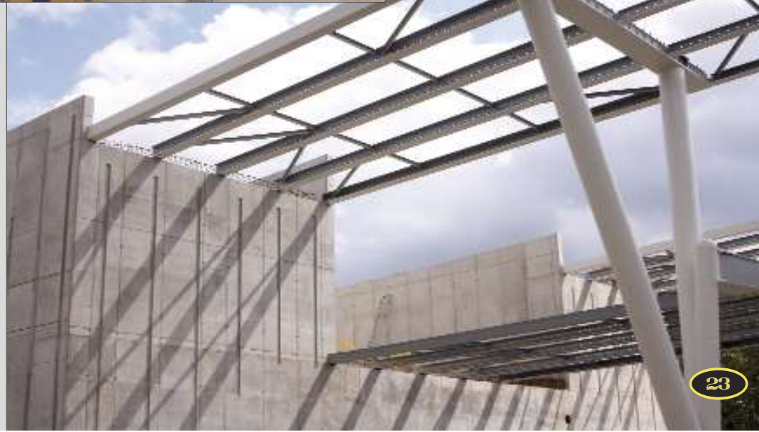
← De brug over de Woluwelaan te Machelen bestaat uit 2 niveaus. Op het bovenste niveau komen de sporen van de toekomstige lijn 25N Schaarbeek – Mechelen; op het onderste niveau komt het enkelspoor 36C/2 dat de luchthaven rechtstreeks met lijn 26 richting Halle zal verbinden. Zo zal een rechtstreekse verbinding met Brussel-Schuman en de Europese wijk mogelijk worden, dankzij de nieuwe tunnel Schuman – Josaphat.. Machelen, 1 mei 2010. Geert PACKET.
