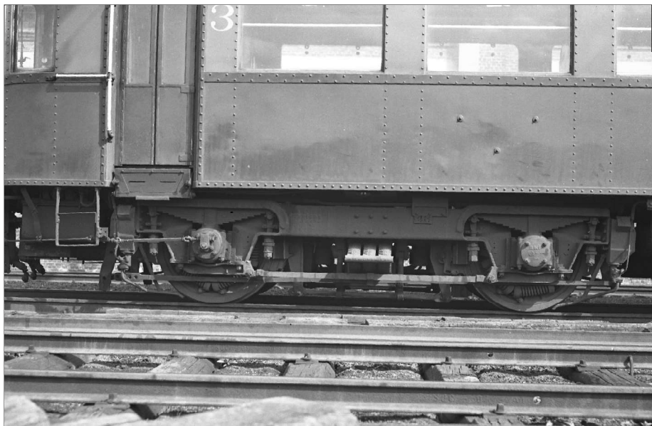
Duidelijk zicht op een motordraaistel. Merk ook de plooideur en het kleine toegangsplatform op. Foto B. DEDONCKER, verzameling TSP ©.
