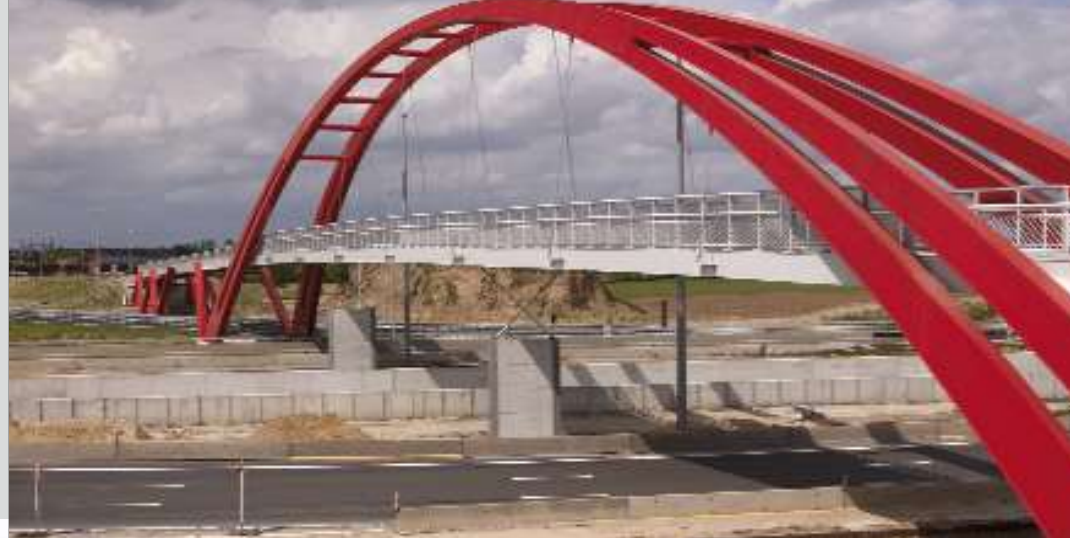
→ Bij de aanleg van een nieuwe spoorlijn wordt dikwijls ook de omgeving aangepakt. Te machelen werd bijvoorbeeld een brug over de sporen en de autosnelweg E19 aangelegd, speciaal voor fietsers en voetgangers. Het spoor naar de luchthaven loopt precies onder het midden van de brug door. Machelen, 1 mei 2010. Geert PACKET.
