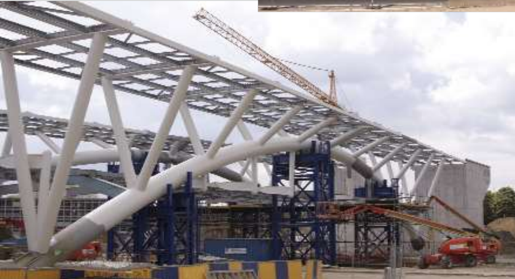
← De brug over de Woluwelaan te Machelen bestaat uit 2 niveaus. Op het bovenste niveau komen de sporen van de toekomstige lijn 25N Schaarbeek – Mechelen; op het onderste niveau komt het enkelspoor 36C/2 dat de luchthaven rechtstreeks met lijn 26 richting Halle zal verbinden. Zo zal een rechtstreekse verbinding met Brussel-Schuman en de Europese wijk mogelijk worden, dankzij de nieuwe tunnel Schuman – Josaphat.. Machelen, 1 mei 2010. Geert PACKET.
