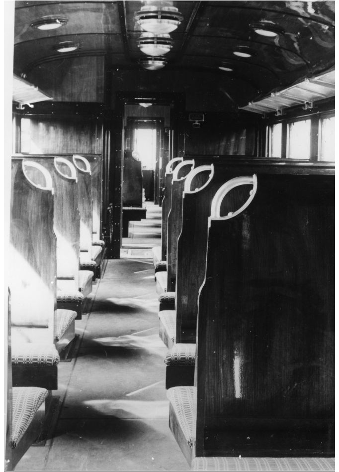
De 3de klasse was ingericht met houten banken in stukhout met uitzondering van de rugleuning in een 2 + 3 opstelling met een middengang.
