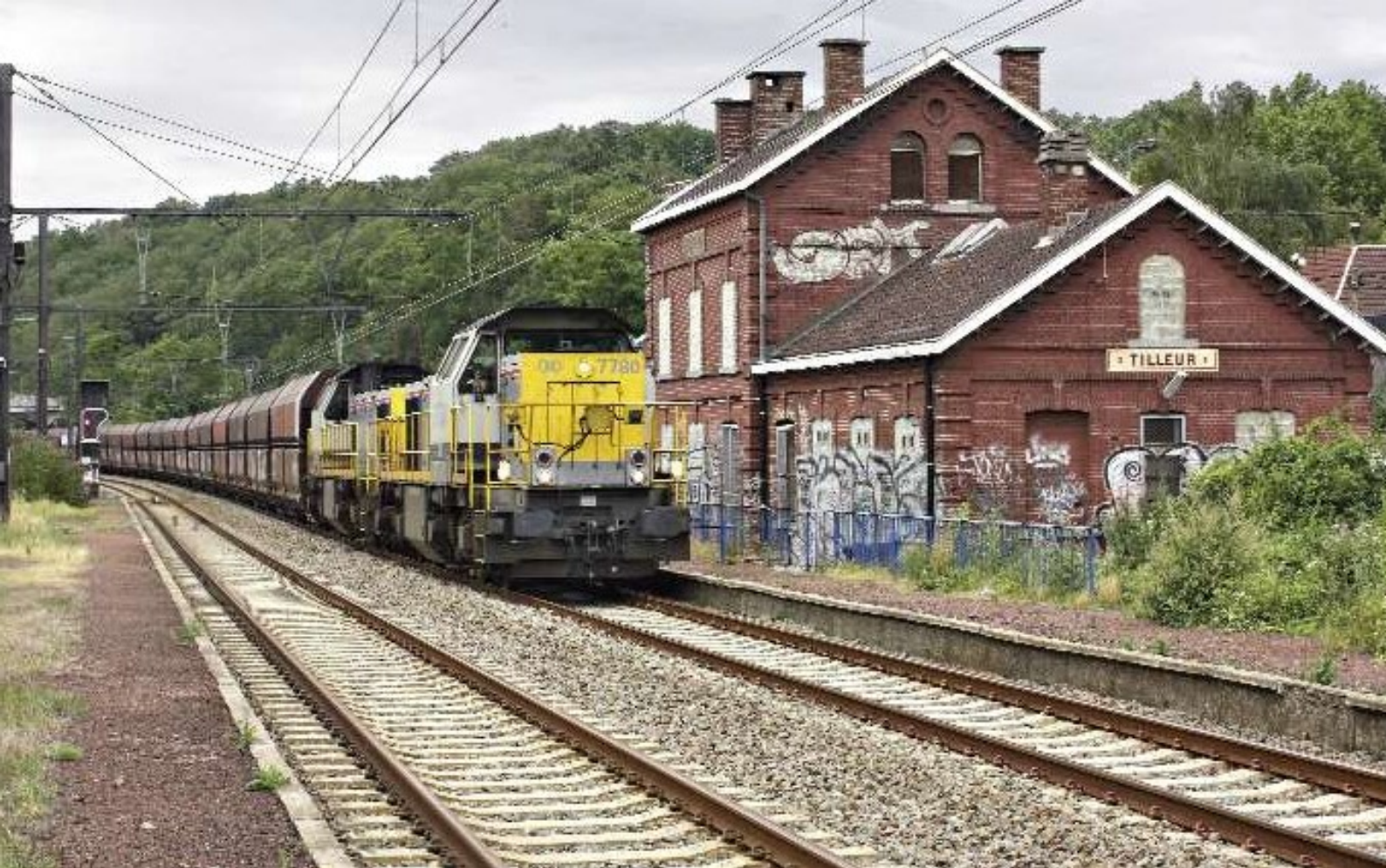
FOTO 99-xx Tijdens het weekend van 7 en 8 augustus was lijn 125A tussen Kinkempois en Flemalle- Haute gesloten voor het uitvoeren van werkzaamheden. Hierdoor werden de goederentreinen omgeleid via lijn 125 tussen Liège-Guillemins en Flémalle-Haute. De treinen werden tussen Liège-Guillemins en Kinkempois gesleept door de reeks 77 in treinschakeling om rangeerbewegingen in de stations te vermijden. Trein 48585 Les Petons - Dillingen, gesleept door de 7780 en 7771 te Tilleur op 7 augustus. Christian AUCQUIERE.
