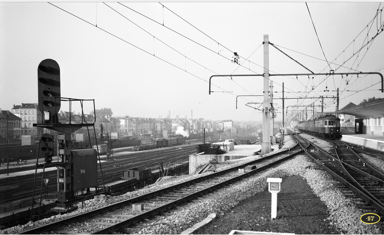
FOTO BD-10102 In 1950 waren de werkzaamheden voor de bouw van de Noord-Zuid-verbinding reeds ver gevorderd. Er zijn reeds drie verhoogde sporen in dienst (de huidige sporen 10, 11 en 12) voor het verwerken van de elektrische treinen tussen Antwerpen en Brussel. De bovenleiding van het "lage" station is reeds verdwenen. Links het wisselcomplex dat toegang verleent tot het oude station en een elektrisch sein "De Rechter". Rechts rijdt een zesledig stel 1935 het station binnen. Het is nog steeds getooid met de oorspronkelijke livrei. Foto Bruno DEDONCKER, verz. TSP ©.
