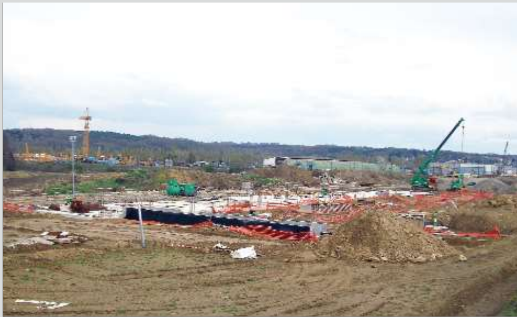
De funderingswerken voor de nieuwe onderhoudspost voor de Desiro-stellen te Ottignies. Deze werkplaats is gelegen aan de inrit van Ottignies, kant Brussel, tussen de lijnen 161 naar Brussel en 139 naar Wavre.
