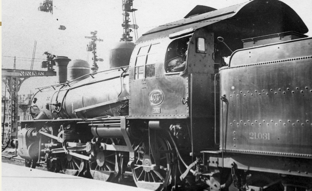
Het type 40 nr. 4031 (ex-4931, ex-ROD 825 - Baldwin 47679 / 1917) in het station van Namur. Ze draagt een ovale plaat, model 1929 van 474 x 304 mm met rode achtergrond. Eronder bevindt zich de eigenaarsplaat: FSU (Baulers). De tenders hadden eveneens ovale platen met daarop hun nummer. Vanaf september 1931 werden deze platen verwijderd en vervangen door een nieuw nummer bestaande uit 4 of 5 cijfers van 100mm hoogte, geschilderd op de zijwanden, 40 mm van de onderste hoeken. De eerste twee cijfers geven de watercapaciteit van de tender weer. In dit geval heeft de tender 21.031 een capaciteit van 21 m 3 . Deze machine werd in december 1964 in Kortrijk geschrapt.
