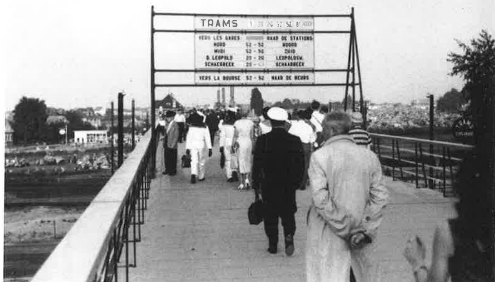
De voetgangersbrug naar het station Esplanade, september 1958.
