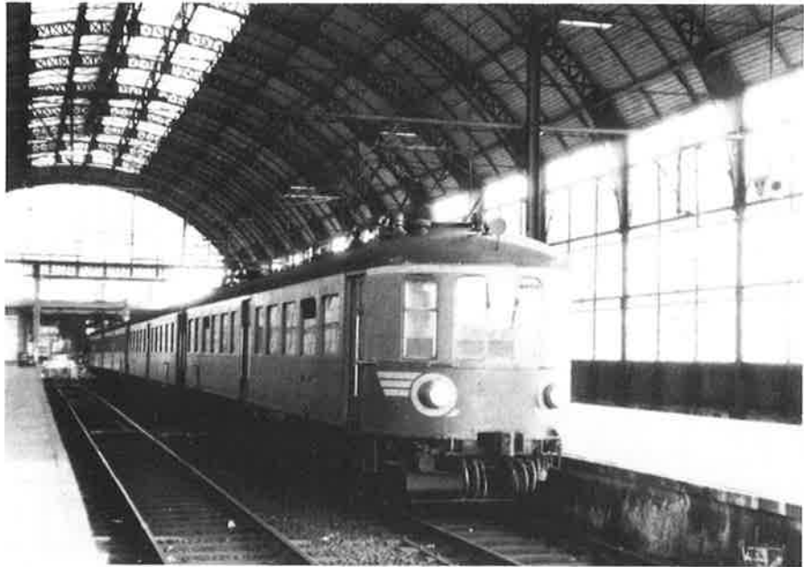
AM 35, gefotografeerd in een ons onbekend station. Vooraleer te worden verbouwd en ingezet als poststellen, reed dit materieel als vierledige stellen reizigersdiensten tot in 1962. Het hier afgebeelde stel nr. 12 werd in 1984/85 gerestaureerd voor museumdoeleinden. Foto Jocadis, verzameling Jan Mahieu.
