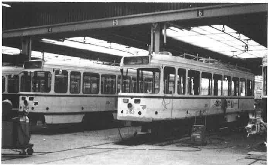
Hoboken, Centrale Werkplaats, 30 juni 1988. De laatste twee crème geschilderde PCC's 2152 en 2154 in grote hernieuwingsbeurt. PCC 2152 werd op 30 mei naar de werkplaats gevoerd, gevolgd door de 2154 op 20 juni. Deze laatste heeft tot voornoemde datum in reserve gestaan en is niet meer in reizigersdienst geweest. Foto E. Keutgens.
