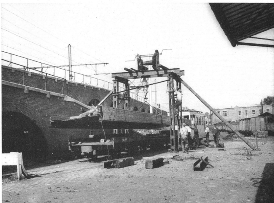
Het laden van een metalen brugelement op NMVB-goederenwagens voor de bouw van de nieuwe brug over het Albertkanaal te Wijnegem in 1952. De elementen kwamen per spoorweg toe om dan per tram naar Wijnegem te worden gebracht. Foto Frans Keutgens.
