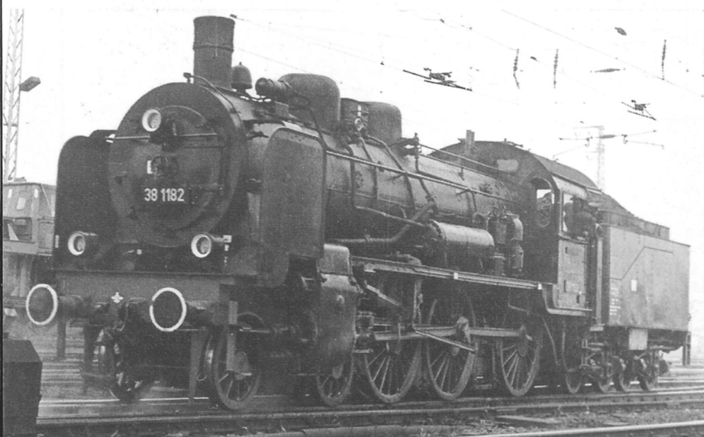
38 1182 zet zich voor de trein in de Lutherstad Wittenberge. Voor de specialisten : deze lok heeft een hangijzer-schuifbeweging (Foto H.D. Waack - Verzameling A. Veys)
