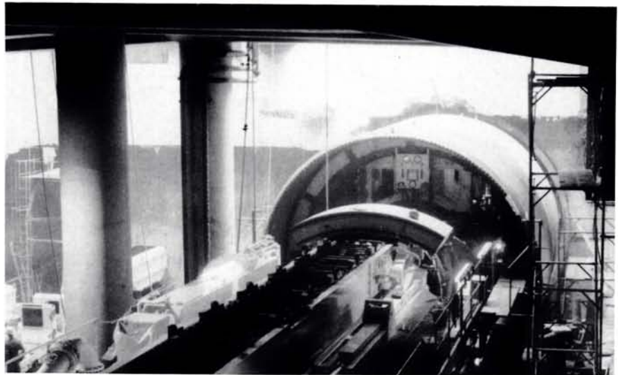
Station Frederik Van Eeden, 10 september 1986. Boorschild „Lange Wapper” is geplaatst voor het boren van de eerste tramkoker onder de Schelde. Op de toevoerlijn naar de „erector” is één van de tunnelsegmenten te zien. Foto Eric Keutgens.
