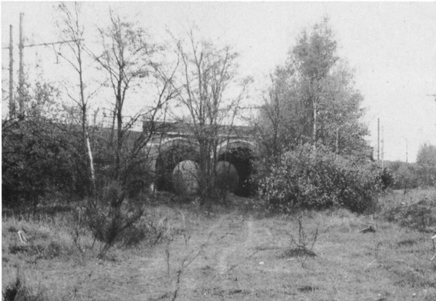
De „ongelijkvloerse kruising” van de lijnen van Mechelen naar Antwerpen en de (opgebroken) lijn naar Antwerpen Zuid. De twee enkelsporige kokers i.p.v. één dubbelsporige waren nodig om het kunstwerk, een klassieke bakstenen konstruktie, bij de beschikbare hoogte voldoende mechanische sterkte te geven. Ondanks de afwezigheid van sporen heerst er in de donkere doorgangen vooral tijdens de zomermaanden nog een druk verkeer.
