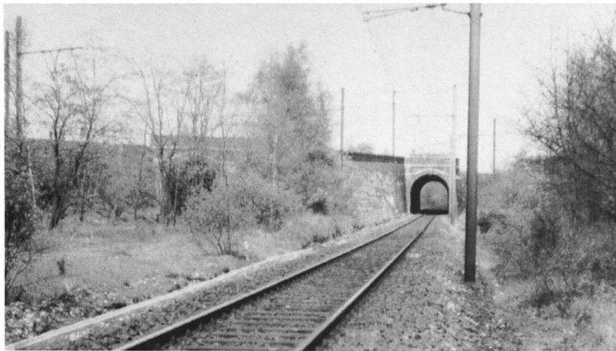
Hier gaat lijn 27B, richting Antwerpen, onder de lijnen 25 en 27. Dit spoor sluit aan op lijn 27, juist voorbij de brug van de R6. Links ziet men de doorsteek van de vroegere lijn naar Antwerpen Zuid. Let ook op de verscheidenheid aan bovenleidingmasten, de steunmuur links van het portaal, de nieuwe kabelgoot voor de seininrichting.
