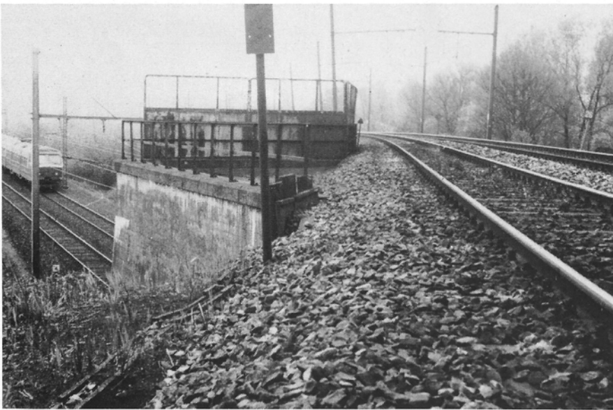
Kilometerpaal 26 van lijn 27 op de brug over lijn 25. Het viertje beneden komt van Mechelen en krijgt zijn stroom uit een bovenleiding die nog opgehangen is aan masten uit 1935. Boven ziet men het onderste deel van een bakken met vijf strepen en de achteroverhellende palen. De stalen borstwering werd verhoogd met een draadraster om te beletten dat iemand een lijfelijke spanningsmeting zou uitvoeren op de onderdoorgaande draden.
