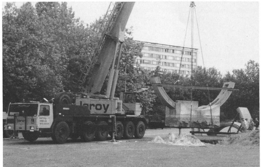
Antwerpen Linkeroever, 7 augustus 1991 : de deels ontmantelde tunnelring werd door een reuzekraan van de firma Laroy zojuist uit de bodem getrokken om op een dieplader te worden geplaatst. Foto Eric Keutgens.
