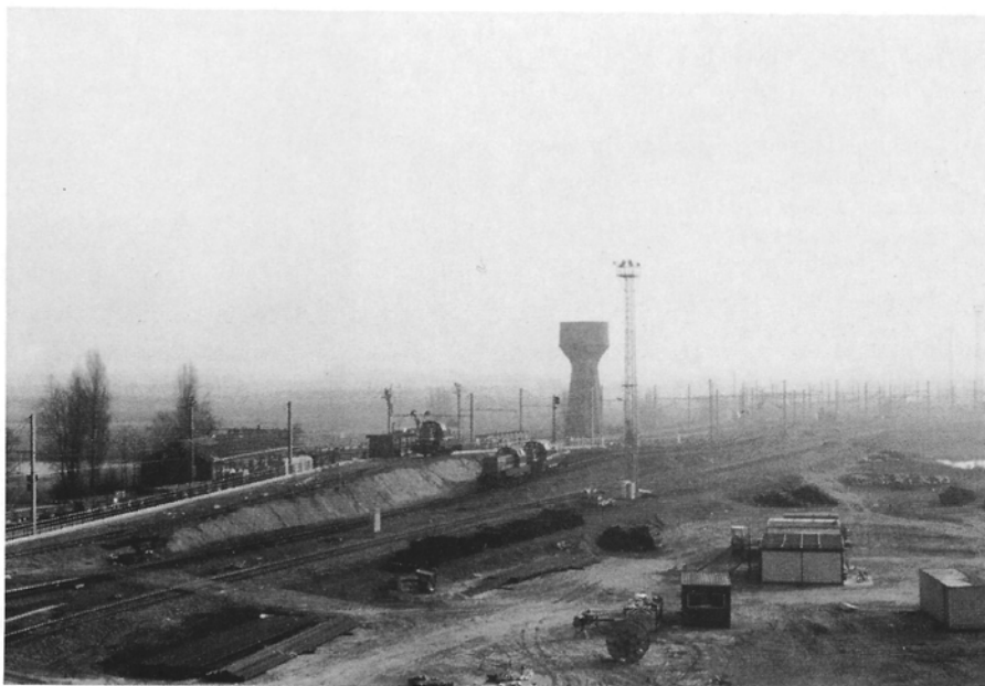
Algemeen gezicht op een rangeerheuvel in een groot vormingsstation. Deze heuvels zijn een onmisbaar element bij het (opnieuw) samenstellen van goederentreinen.
