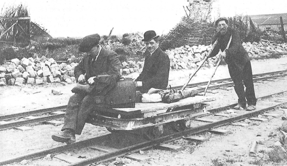
Station de Nimy-Maisières.
