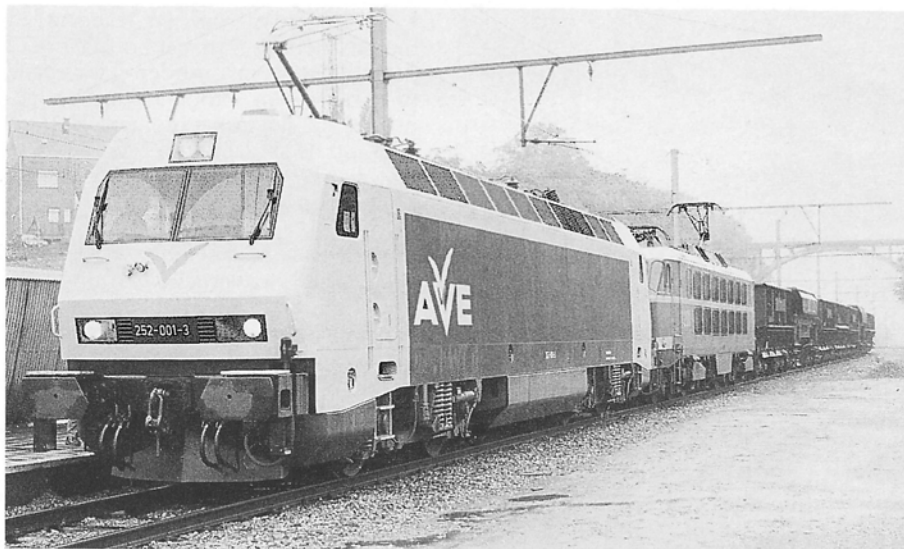
Op 21 juni sleepte meerstromer 252.001 als proefflokomotief een tiental ertswagens (800 ton) van Leuven naar Libramont. We zien hier trein E95855 te Mont-Saint-Guibert met als tweede lokomotief en reservemachine onze 2011. Hier diende de 252.001 na stilstand terug aan te zetten op de steile helling van lijn 161. Foto Willy Henderikx.
