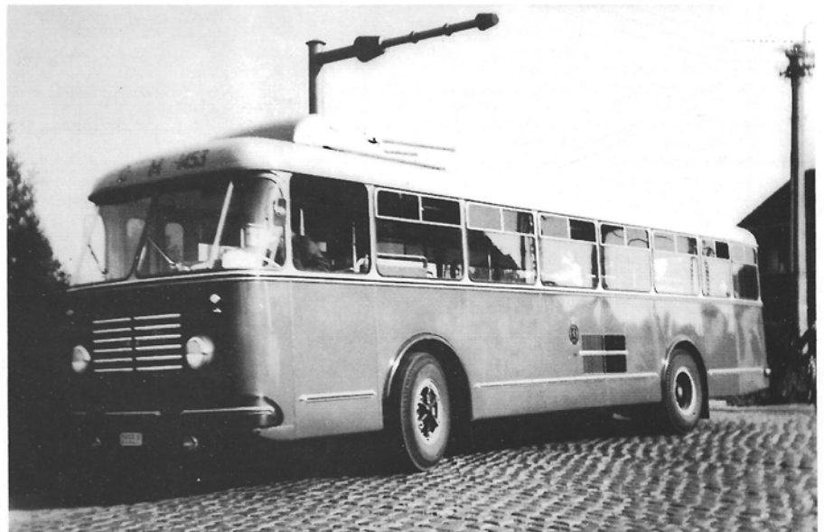
De G2 onder een voedingsmast te Merelbeke. De stroomafname-„antennes” liggen nog vlak. Foto Jacques Cohn.
