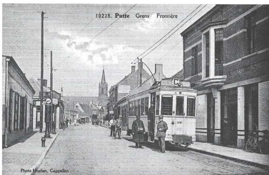
Putte (Nederlandse grens). Deze prentkaart van fotograaf Hoelen toont ons de 9707 aan het eindpunt van de lijn, met koersbord „C” Klapdorp - Capellen. Bemerkt aan het front van het rijtuig de bevestigingshaken voor de verplaatsbare lantaarn met ernaast de stekkerdoos voor de elektrische verbinding. Alle documenten behoren tot het archief van de auteur.
