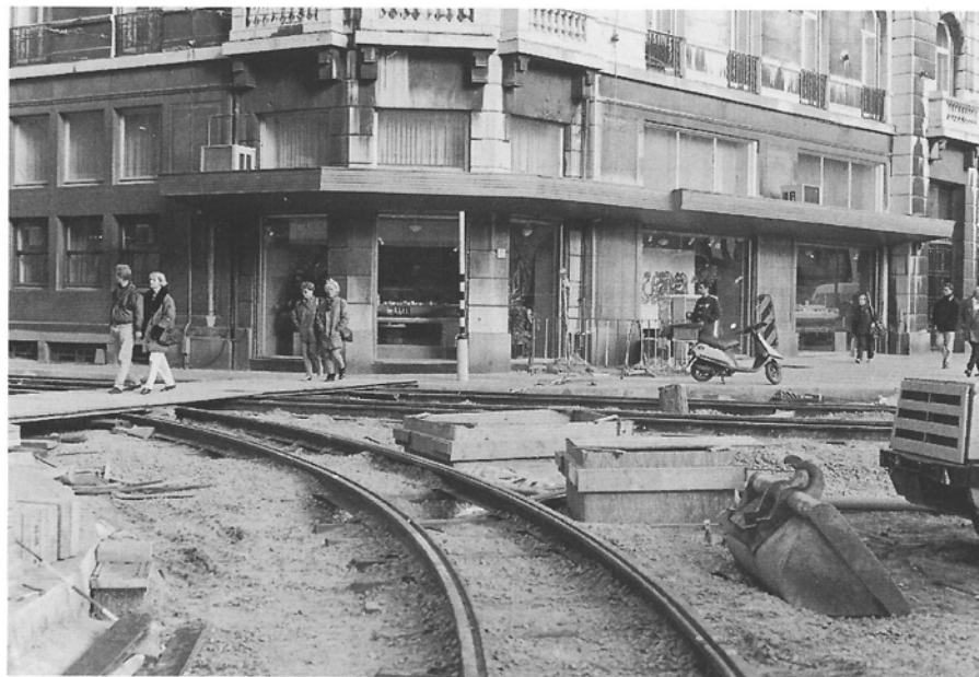
Meirbrug, 15 oktober 1992 : het eerste stuk vanaf de Katelijnevest richting Groenplaats afbuigende spoor ten behoeve van lijn 4 heeft gestalte gekregen. Foto Staf Cuyt.
