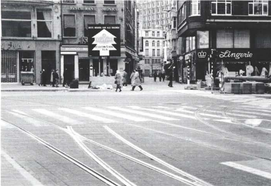
Op 24 januari 1993 ontbraken, ondanks de reeds aangelegde bestrating, nog steeds de spookruisingen van lijn 4 met de lijnen 7 en 8 wat hier, aan het begin van de Katelijnevest, duidelijk te zien is ! Foto Alex Krakowsky.
