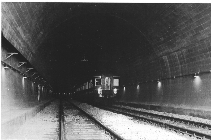
Elektrisch motorstel 228.610 (type 66) tijdens traktieproeven in de Kennedytunnel in 1970. Met de aanleg van deze tunnel ontstond de gedroomde mogelijkheid om tussen Antwerpen en Gent een rechtstreekse spoorverbinding te creëren. Foto NMBS.
