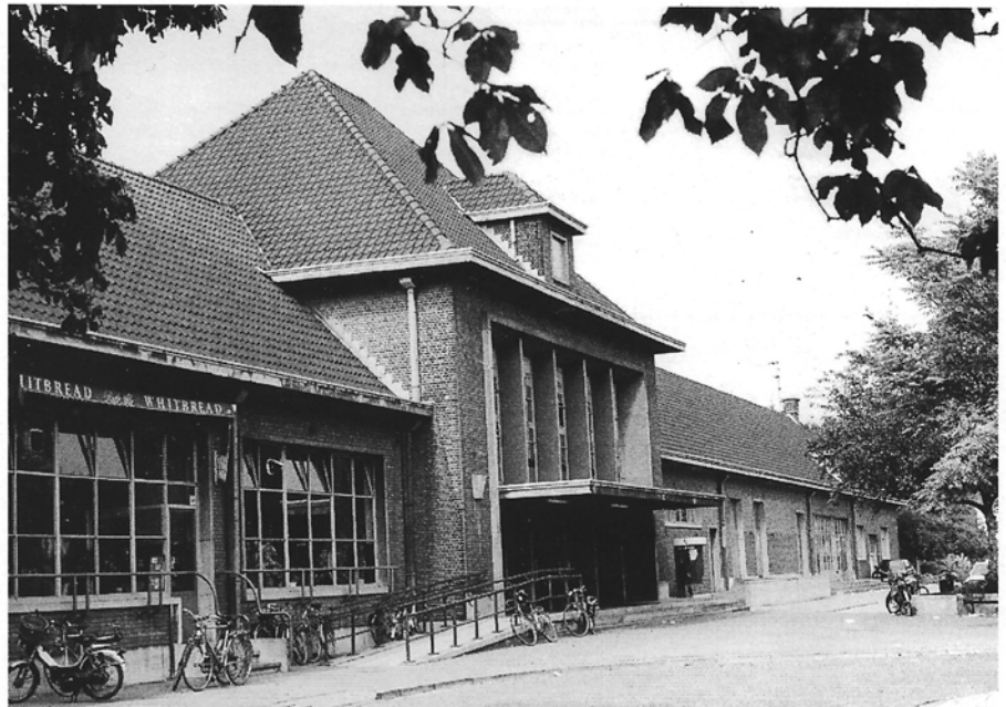
Het prachtige stationsgebouw van Lokeren is enigszins in het groen weggestoken. Spijtig, dat bij de uitbreiding van het stationsplein koning auto zijn plaats tussen de mooie aanplantingen heeft opgeëist. In tegenstelling tot St-Niklaas bleef het stationsgebouw van Lokeren, dat dateert van na de Tweede Wereldoorlog, behouden. Foto Jan Mahieu.
