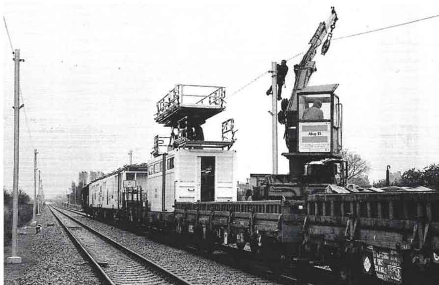
Spoorlijn 94 Tournai - Lille werd geëlektrificeerd en op 25 mei 1993 als zodanig officieel ingehuldigd. De foto toont de eerste fase van het aanbrengen van de bovenleiding. Foto NMBS.
