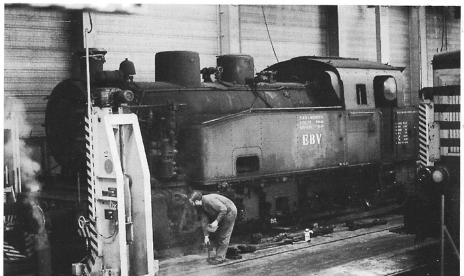
Duvel, toen nog Anna 2, in het NMBS-werkhuis Montzen. De machine is gelicht en het volledige drijfwerk verwijderd.
