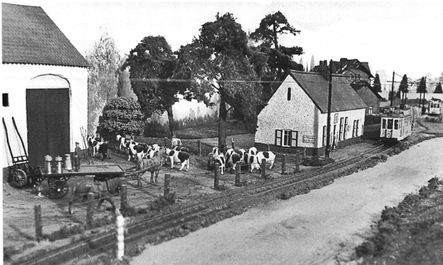
Standaardtram in een zeer landelijke omgeving, met een typische situatie voor de buurtspoorwegen : de tram in een eigen bedding naast de straat.
