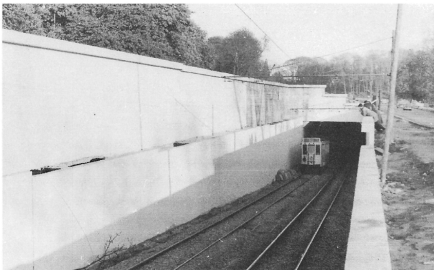
Laken, april 1957. Tramhelling en tunnelingang kant Meiselaan (voor trams naar Londerzeel). Een standaardmotorrijtuig in dienst op lijn S (Strombeek) komt uit de tunnel (tijdelijke reisweg). De over de hellingmuur kijkende eerste persoon is de auteur van deze bijdrage. Foto Frans Keutgens.
