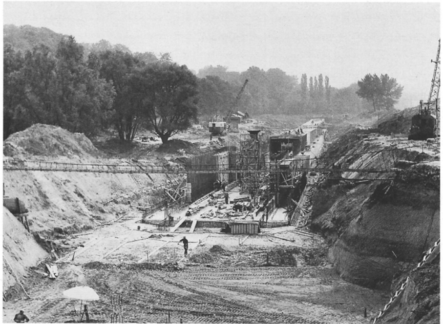
Park van Laken, Expoterrein, 15 september 1956. Op de voorgrond : de bouw van de ondergrondse halte. Rechts het begin van de uitgravingen richting Londerzeel. Foto E. Roels, verzameling Eric Keutgens.
