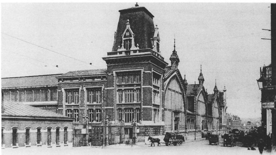
Het stationsgebouw Brussel-TT. De drie grote metalen overkappingen worden van elkaar gescheiden door twee kleine. In totaal zijn er dus vijf loodsen. Het loodsencomplex wordt geflankeerd door twee bakstenen gebouwen, bestemd voor de administratieve diensten, de loketten, de post enz. In de achtergrond, aan het einde van de Picardstraat, bevindt zich het douanegebouw. Opname : na W.O. I (?). Prentkaart : verzameling P. Pastiels.
