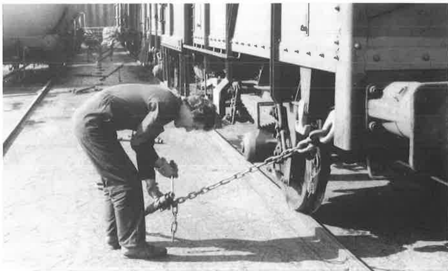
...om tenslotte middels handkracht te worden verankerd. (Foto's K. Hoggett)
