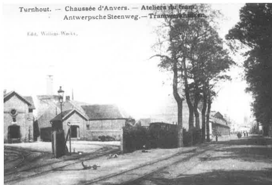
Turnhout, de Antwerpsesteenweg met de inrij van de stelplaats. Uiterst rechts het eerste stationsgebouw met bureaus en magazijn (opgericht in 1891) met eraan het goederenmagazijn (opgericht 1896). De gebouwen in de achtergrond zijn geen NMVB-installaties.
