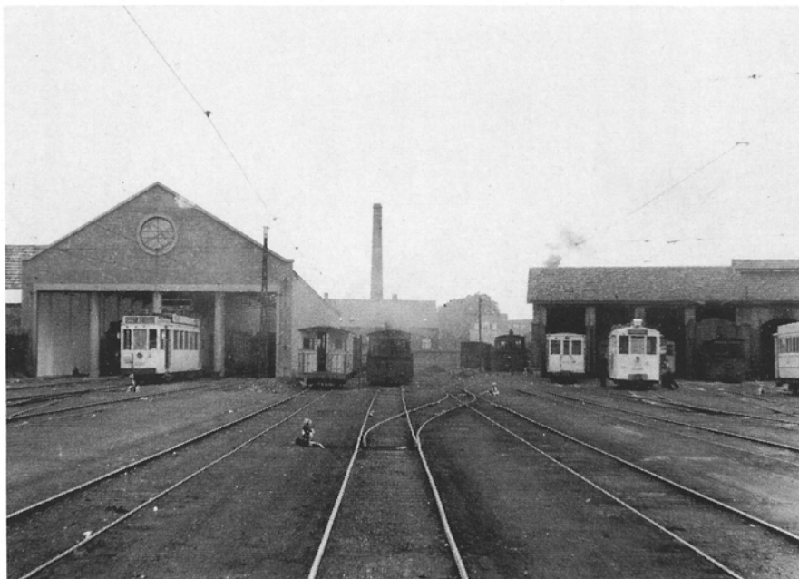
Turnhout-stelplaats. Mei 1947. De stoomtraktie heeft nog niet afgedaan. Links de tramloods, opgericht in 1942-1943 met materialen afkomstig van de sloping van een deel van de tramloods voor elektrische rijtuigen te Berchem, Zurenborg. Rechts de oude loodsen voor de stoomtraktie. Foto A.G. Nymeyer.
