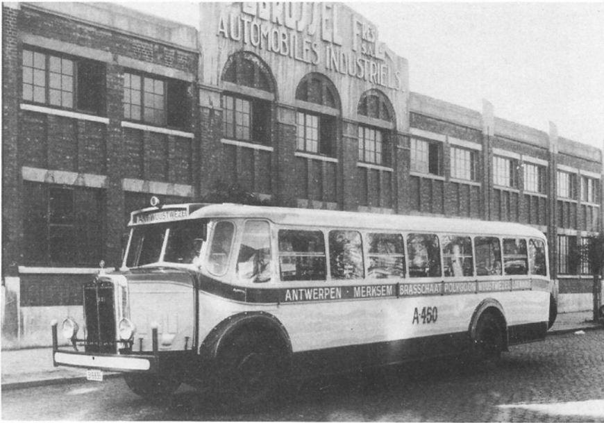
Autobus A.450. Een prachtige bus in 1937 gebouwd op een Brossel onderstel door de „Carrosserie Bostovo” te Lier. Foto : Origineel W. Ceulemans, Halle. Verzameling Ch. Smits.
