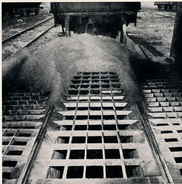
Figuren 1-2. Wagenkipper benuttigd in de betonstuttenfabriek van de N.V. Kolenmijnen Helchteren-Zolder te Zolder (lossen van zand)
