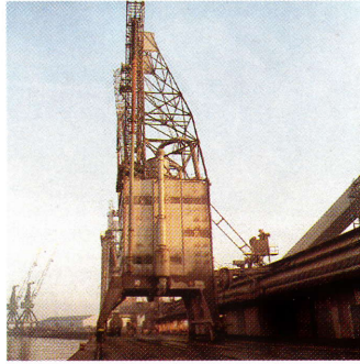
4. 2 pneumatische zuigers om granen te lossen.
