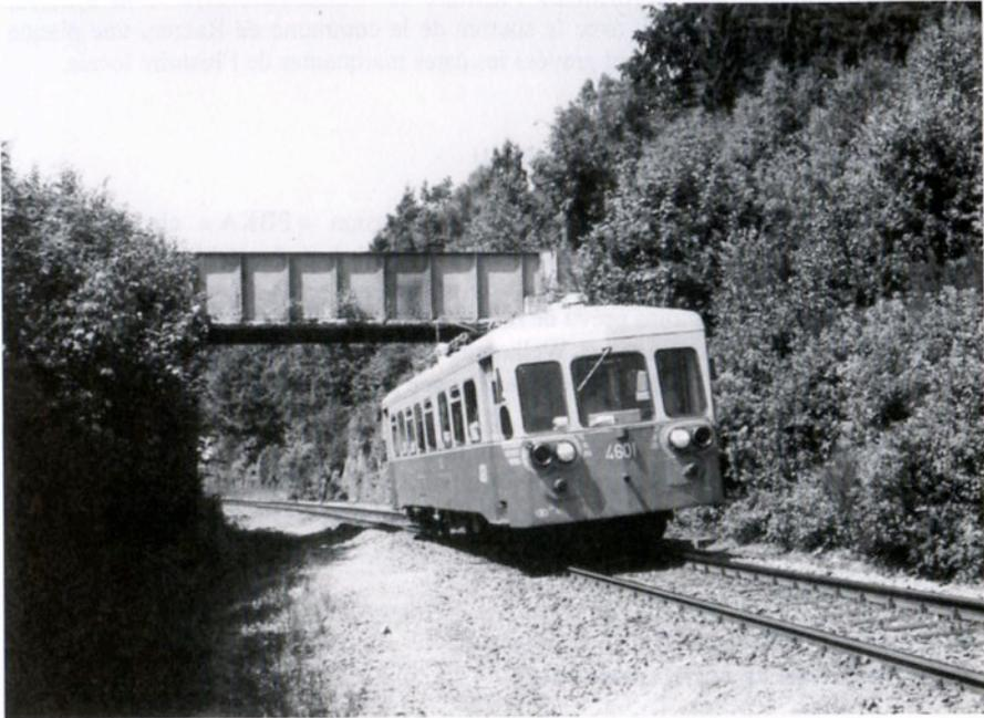
**Tous les ponts « Cockerill » qui parsèment la ligne 42 doivent être le plus souvent reconstruits pour être adaptés au gabarit électrique (voyage spécial GTF - 5 août 1995 - photo J. Ferrière)**
