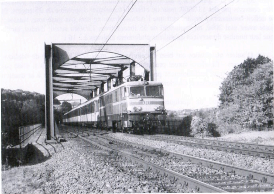
Cette photo appartient au passé : locomotive tritension 1502 en tête, l'EC 33 Parsifal, aujourd'hui évincé par les TGV « Thalys », franchit le pont-rail sur la Sambre à Floriffoux (ligne 130) le 2 octobre 1997 (photo M. Lebeau)
