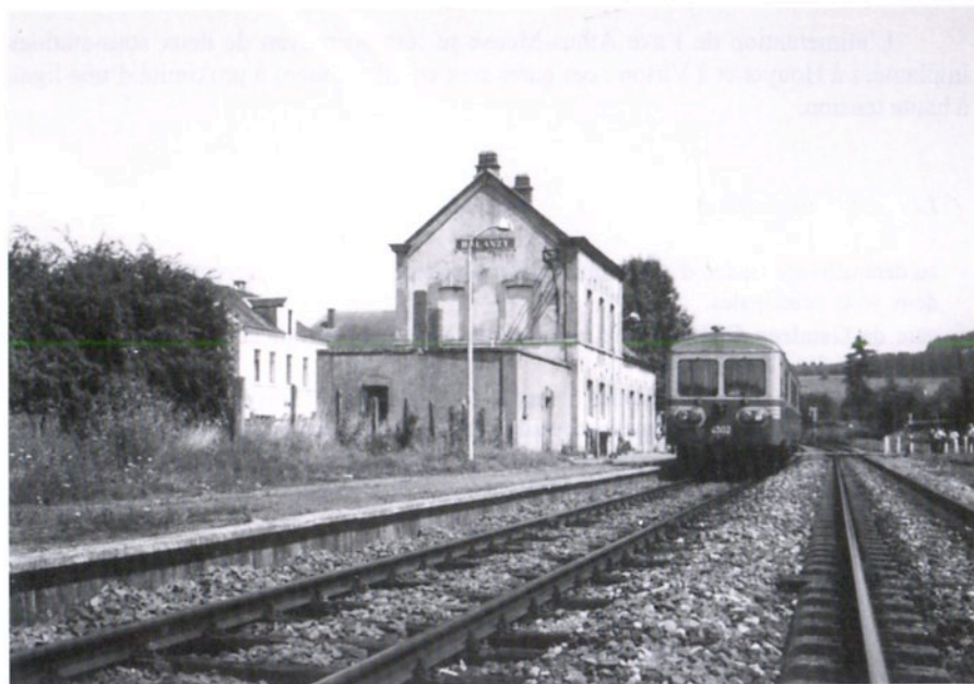
Pour remettre la gare d'Halanzy en service, il suffirait de réaménager ses quais (photo R. Marganne - 25 juillet 1992)
