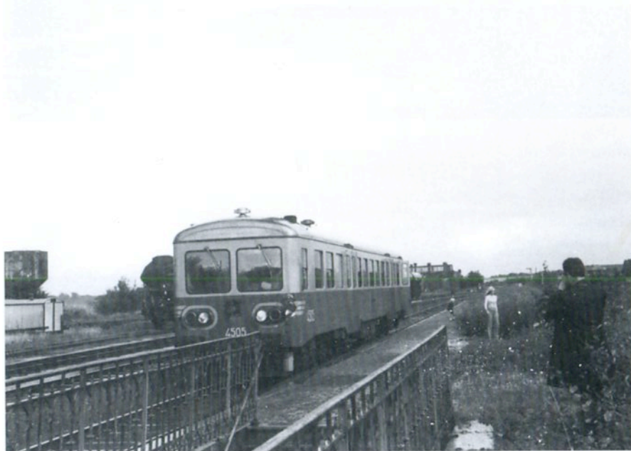
Florennes (Central) - voie 7 : en avant-plan, couloir sous-voies ; au fond, remise à locomotives (voyage GTF asbl du 19/8/72 - photo J. Bazin)
