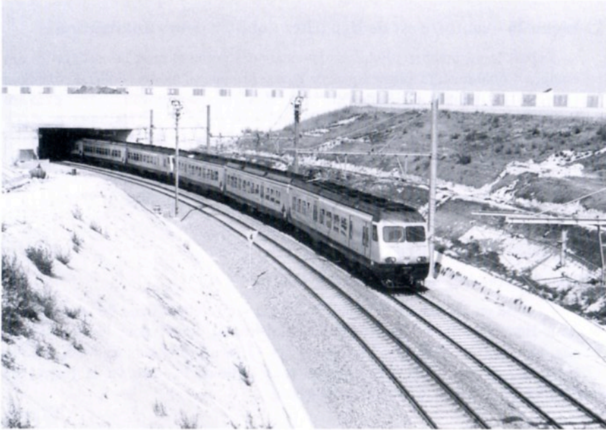
Un train IR pour Bruxelles, Mons et Quévy sort de la « tranchée souterraine » de l'aéroport à Zaventem (photo M. Grieten - 19.08.98)
