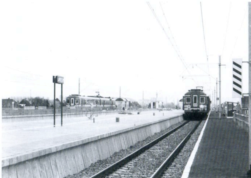
Les travaux de quadruplement à Landegem le 28 mars 1998 (photo M. Grieten)
