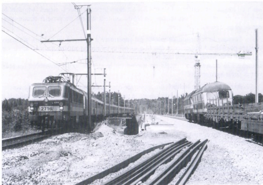
Hammerbücke en chantier - 17.05.99 : à gauche, train IC Cologne - Ostende à contre-voie ; à droite, train d'électrification tiré par les 5950 et 5905 sur la nouvelle voie « B » franchissant la « nouvelle » Hammerbrücke (photo M. Grieten)
