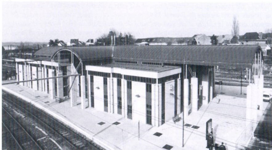
Nouveau bâtiment d'Ottignies (photo SNCB)
