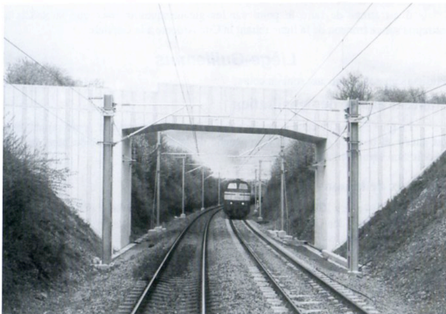
Image de l'Athus-Meuse modernisée : caténaires et ouvrage d'art reconstruit entre Vonêche et Pondrôme. Croisement avec un train de marchandises tracté par la locomotive diesel 5214 (23.04.99)
