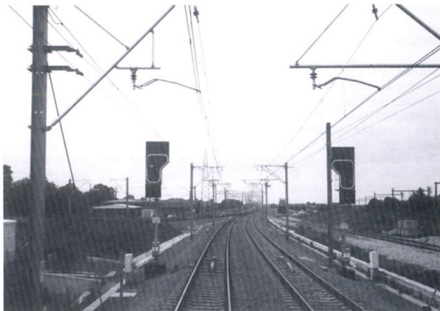
↑ Ans , voie 5 : à droite, site de la future base de maintenance de la LGV. ↓ Y Voroux : de droite à gauche, mâts caténaires de l'ancienne ligne 36, voie d'accès à la base travaux LGV, ligne 36 nouvelle vers Fexhe-le-Haut-Clocher, ligne 36A en provenance de Kinkempois.
