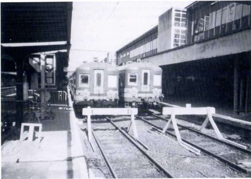
Les voies 6 et 7 de Liège-Guillemins ont été mises en cul de sac côté Angleur (photo R. Marganne - 26.09.99)
