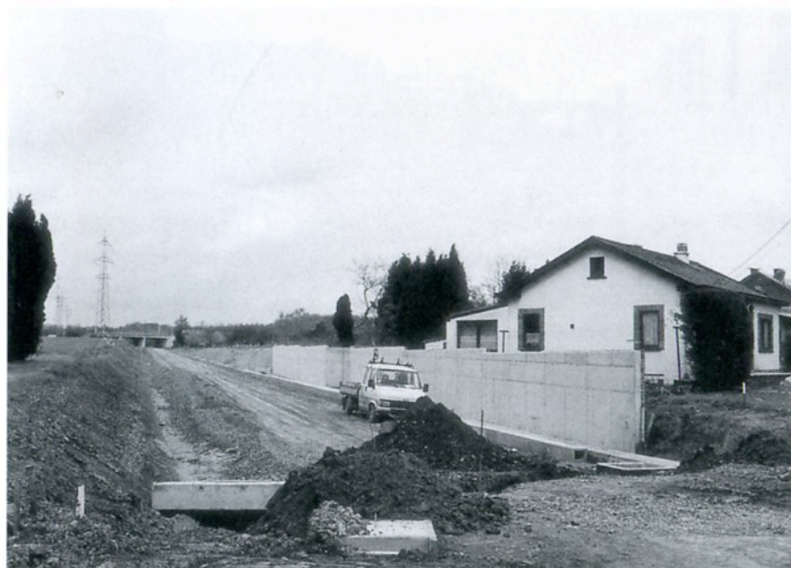
L'assiette de la ligne 147 (nouvelle) à Tamines, au passage à niveau de la RN 988 (vue vers Fleurus - photo M. Grieten - 19.04.00)
