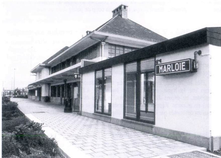
La gare de Marloie rénovée (photo SNCB)
