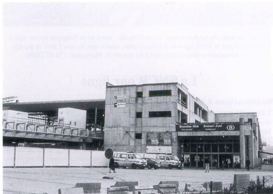
Bruxelles-Midi le 30.04.00 : pose du « viaduc » de prolongement de la voie 3 (photo M. Grieten)
