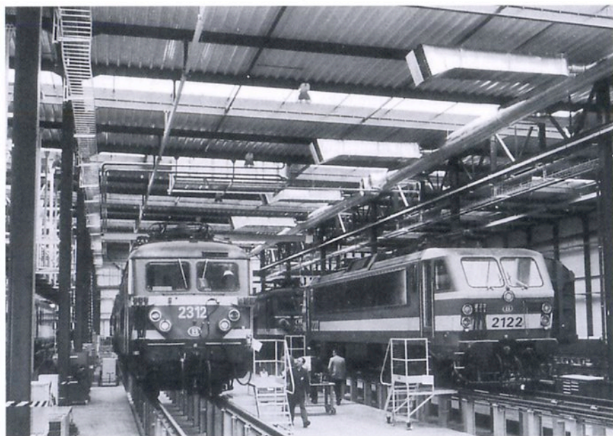
Locomotives 2312 et 2122 à l'entretien au nouvel atelier d' Anvers-Nord à l'arrière-plan, la 2558 (photo M. Grieten - 28.05.00- portes ouvertes)
