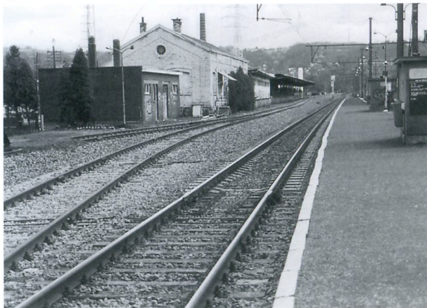
Gare de Chênée, vue vers Verviers. Venant du nouvel aiguillage (avant gauche), la voie de chantier occupe l'espace resté libre le long des hangars de l'ancienne usine Cuivre et Zinc. Dans le fond, la séparation ligne 38 vers la gauche et ligne 37 vers la droite (février 2000)
