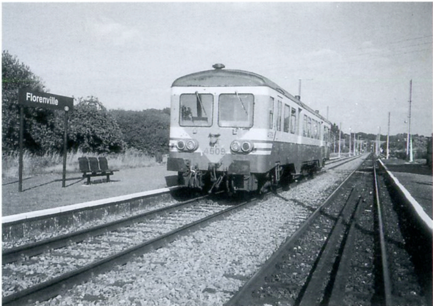
A Florenville, seuls les poteaux sont plantés : pour les caténaires, il faudra encore patienter (photo R. Marganne - 11.07.00)
