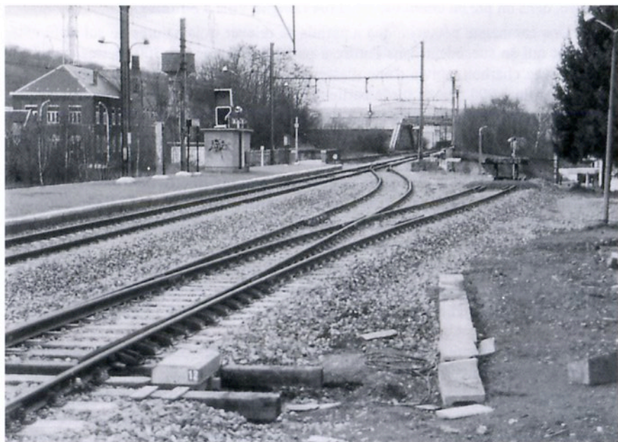
Entrée de la gare de Chênée, côté Liège. De part et d'autre du quai, les deux voies de la ligne 37, à l'arrière au centre, des hangars de la « Vieille Montagne » et devant, la voie nouvellement posée avec son aiguillage de raccordement à l'ancienne ligne 37 (février 2000)
