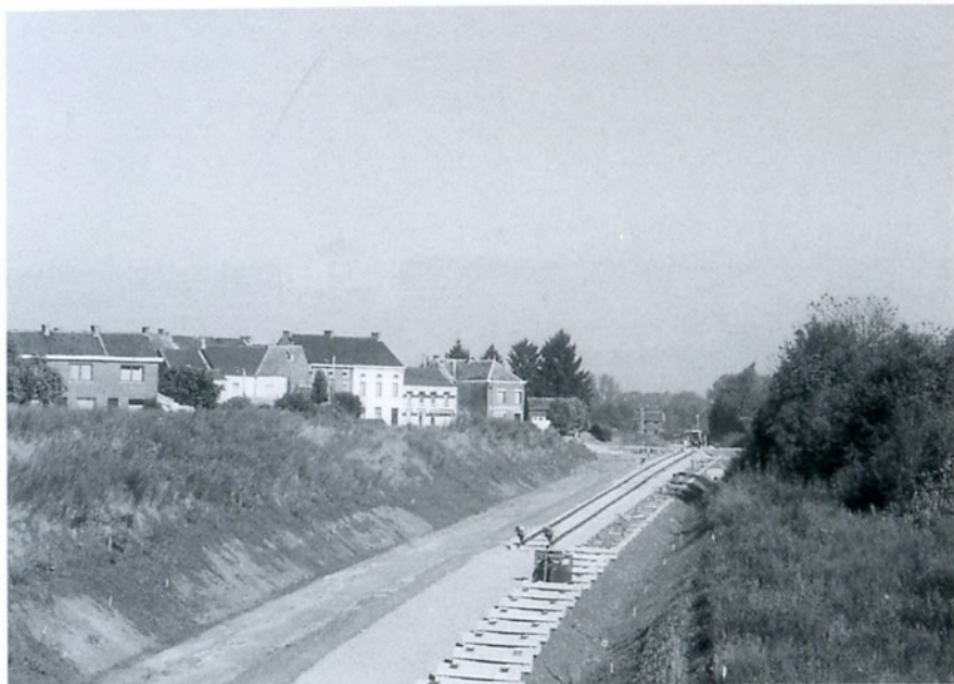
Lambusart (ligne 147) : travaux de pose de la voie par l'entreprise Strukton, la photo est prise en direction de Fleurus (photo M. Grieten - 21.09.00)
