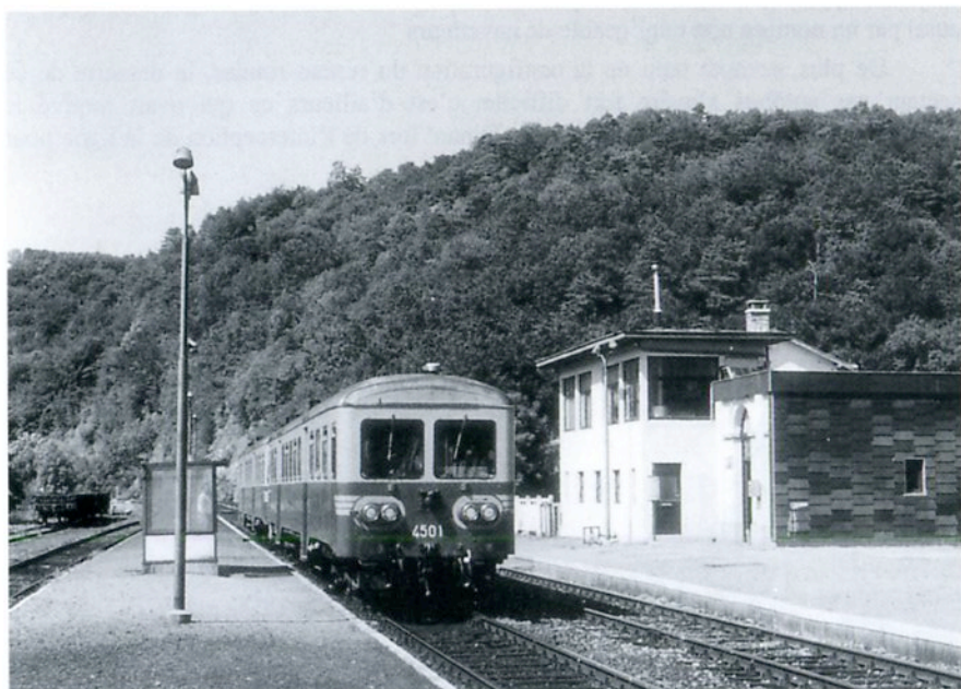
Passage d'un couplage d'autorails « rouge - rouge » (4506 + 4501) en gare de Gendron-Celles avant le début des travaux d'électrification. On remarque sur la gauche du cliché la voie de garage n°4 en impasse encore présente à cette époque. A droite, le bâtiment du block 3 (12.07.94) - photo J. Perenon
