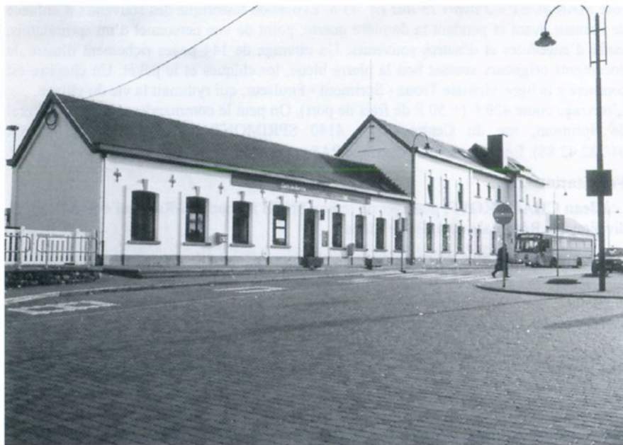
la gare de Bertrix rénovée, côté ville (photo D. Moinil - SNCB)
