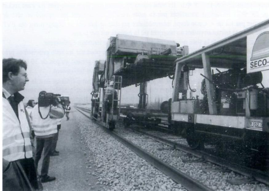
← Le portique sur pneu dépose un PVP en tête de ligne (amont) sur une plateforme parfaitement plane, bordée des caniveaux de drainage et de câblerie.
