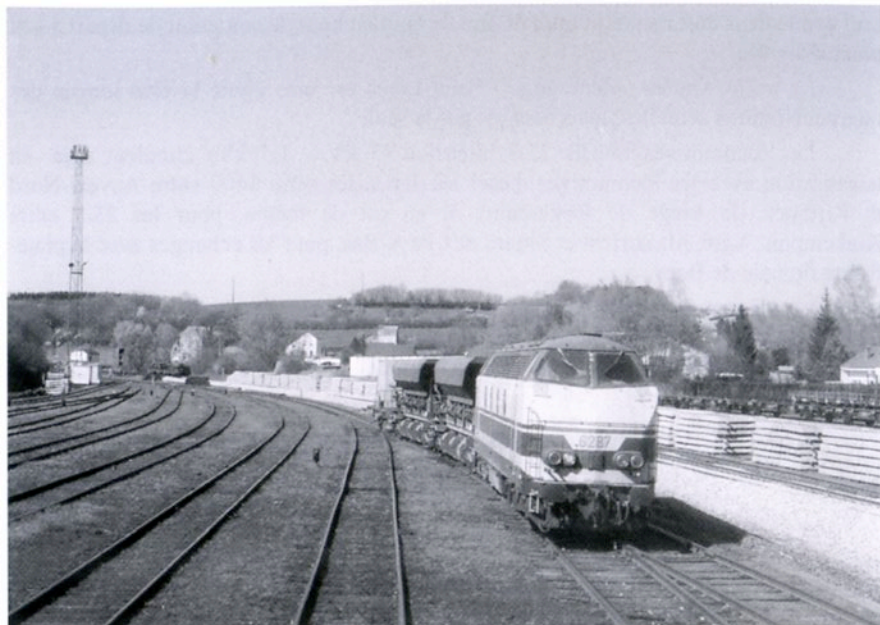
Athus : Passage d'un train de travaux tracté par la 6287 sur les voies du faisceau « Madagascar ». A droite, on distingue le chantier de renouvellement de la voie principale se dirigeant vers Arlon. 08/04/2002 (photo J. Perenon)
