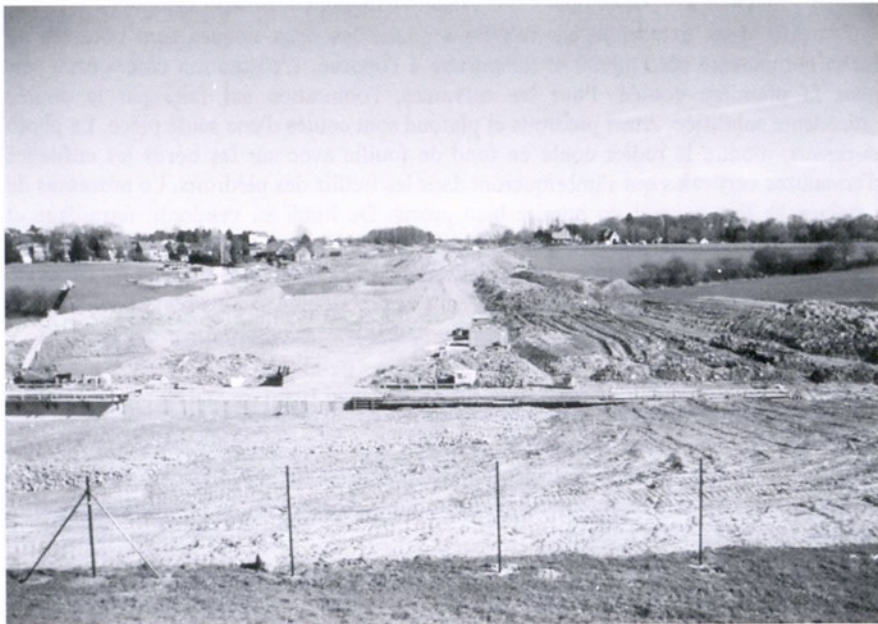
Juste avant la rue des Carmes, l'ouvrage hydraulique OH 6416 canalise sous la LGV le ruisseau des Marais qui se dirige à droite vers la Magne. A l'avant, la clôture qui ferme le chantier du tunnel. (Ayeneux le 7 avril 2002)
